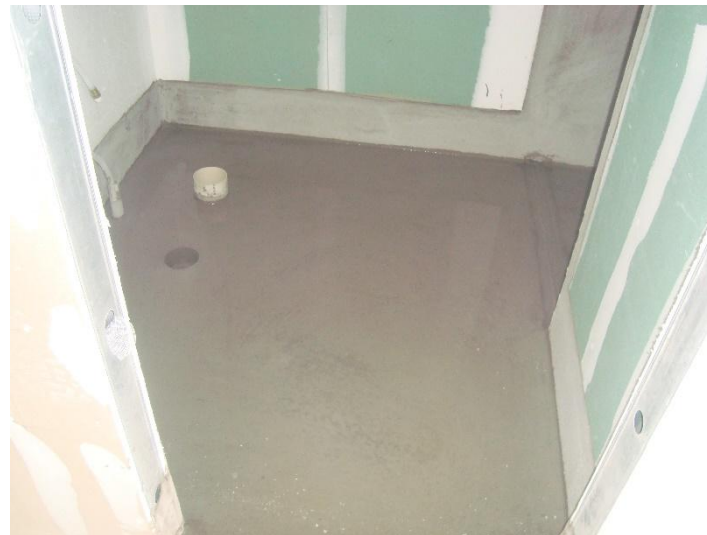
Impermeabilização – 14º Pav
