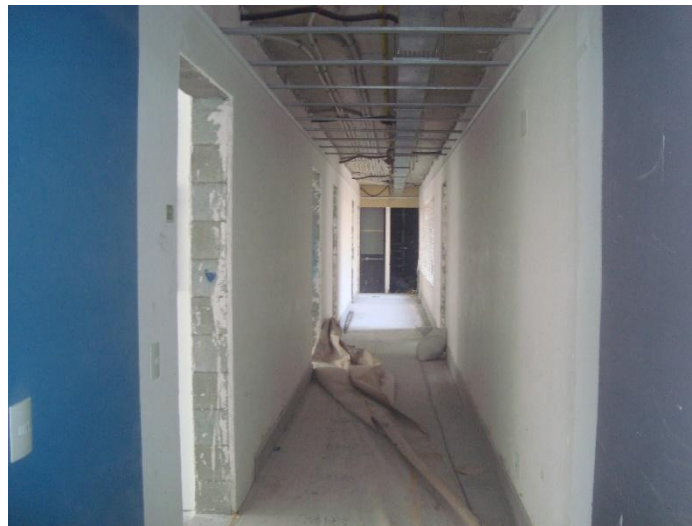
Estrutura para Forro – 4º Pav
