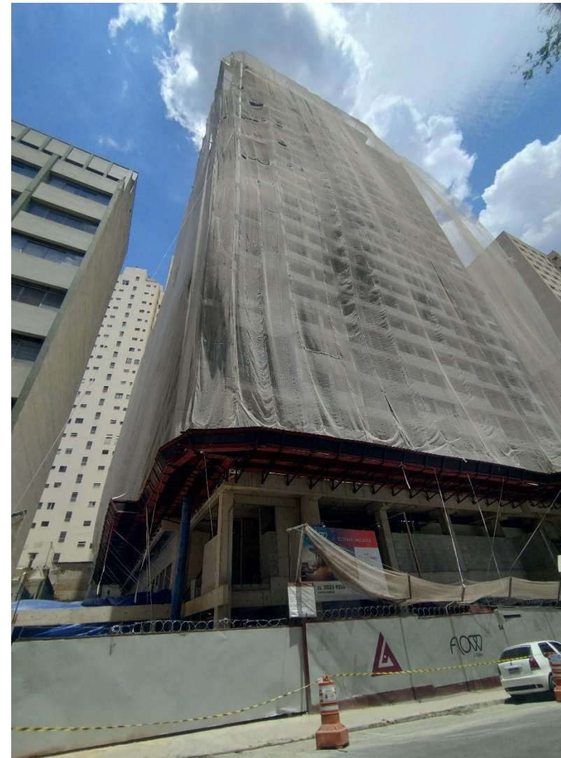
Vista Fachada 28/Nov/24
