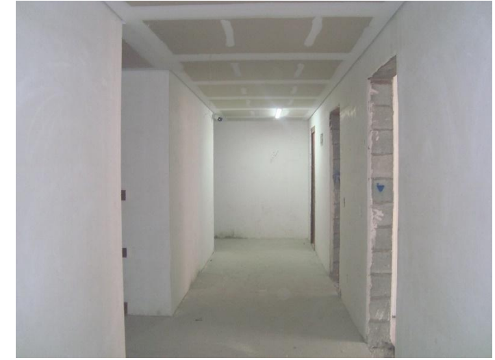
Forro de Gesso – 2º Pav
