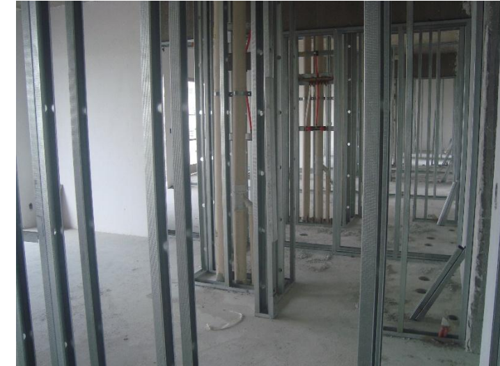
Estrutura Drywall – 22º Pav
