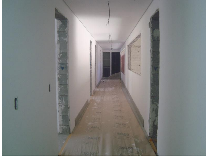
Pintura Interna – 3º Pav
