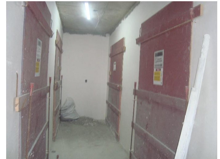
Proteção de Vãos de Elevadores
