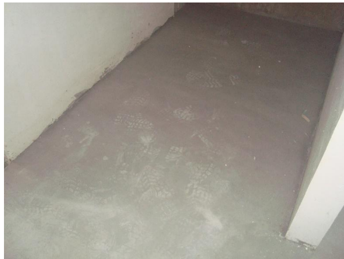
Contrapiso – 19º Pav
