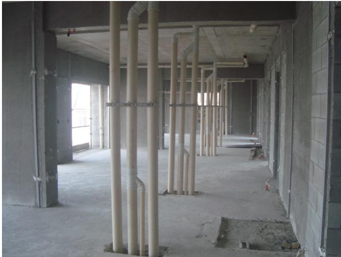
Prumadas Hidráulicas – 24º Pav
