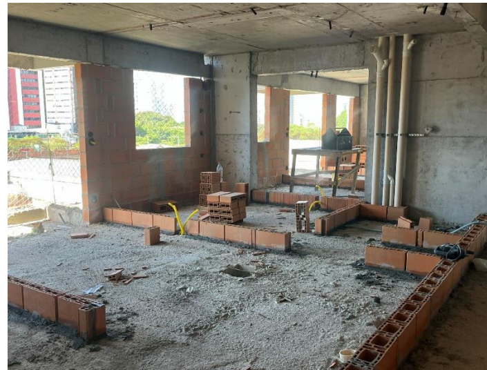
Marcação de Alvenaria – 7º Pav
