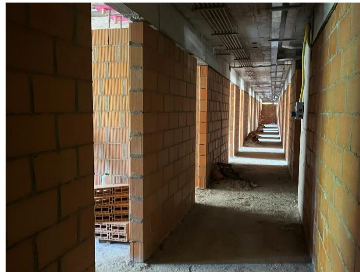
Alvenaria/ Fechamento – 3º Pav
