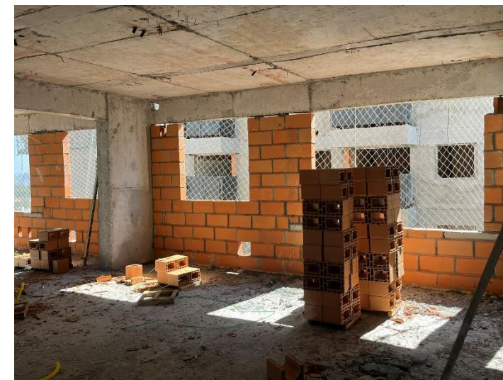
Alvenaria/ Fechamento – 15º Pav
