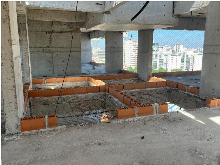
Marcação de Alvenaria – 17º Pav
