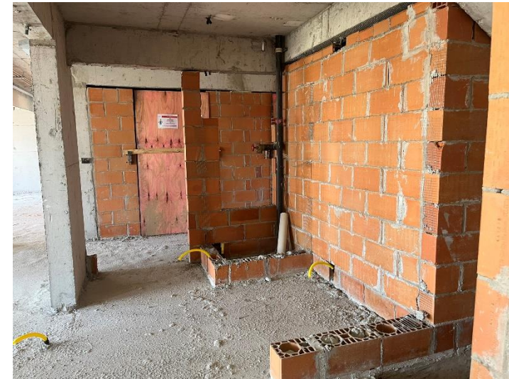
Alvenaria/ Fechamento – 9º Pav
