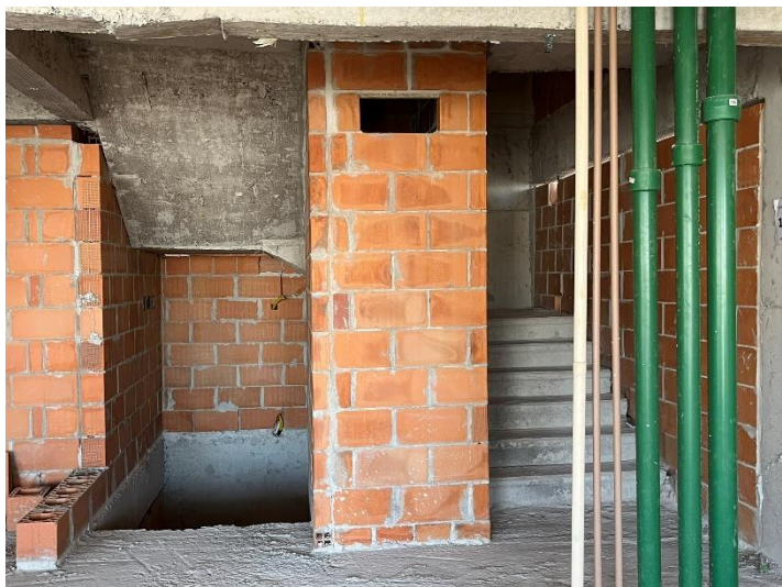
Alvenaria/ Fechamento – 13º Pav
