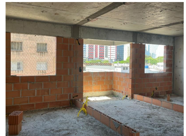
Alvenaria/ Fechamento – 5º Pav
