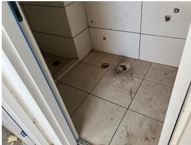
Piso Cerâmico – 22º Pav
