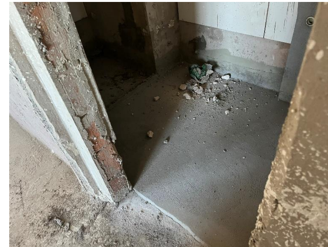
Contrapiso – 25º Pav
