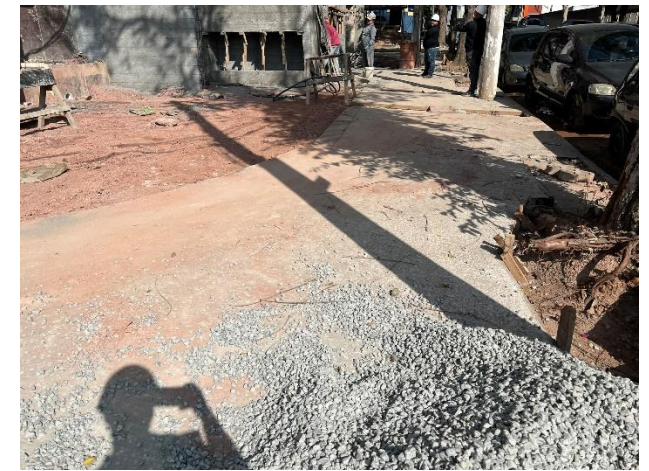
Execução de Calçada
