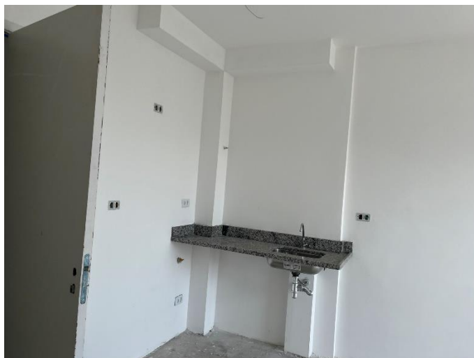
Pintura Interna – 4º Pav
