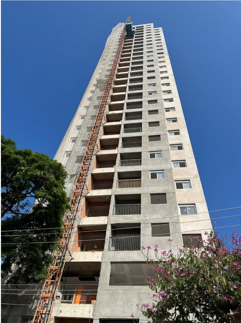
Vista da Fachada Frontal
