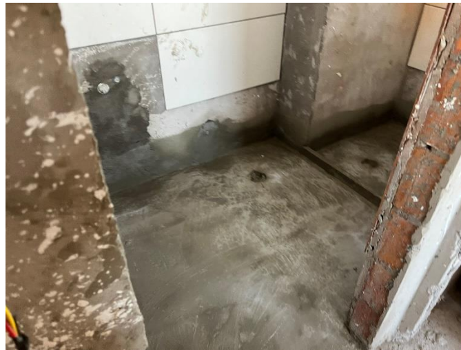
Impermeabilização – 26º Pav
