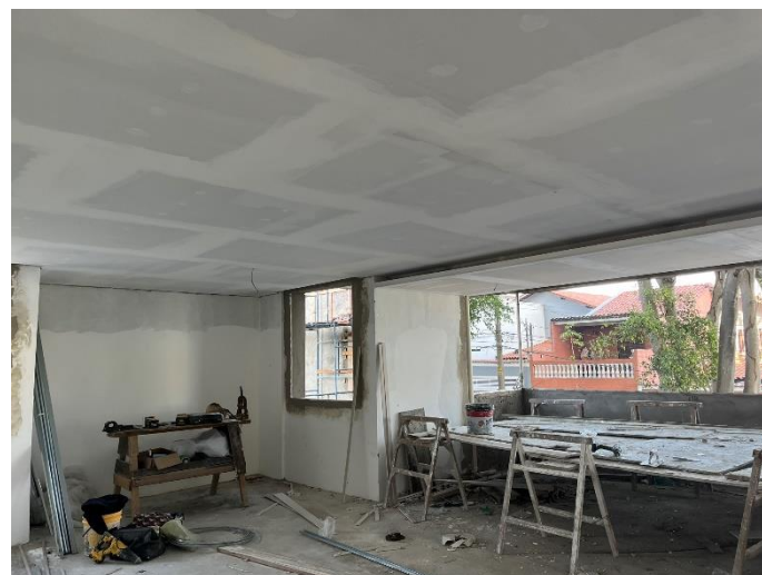
Forro de Gesso – 1º Pav
