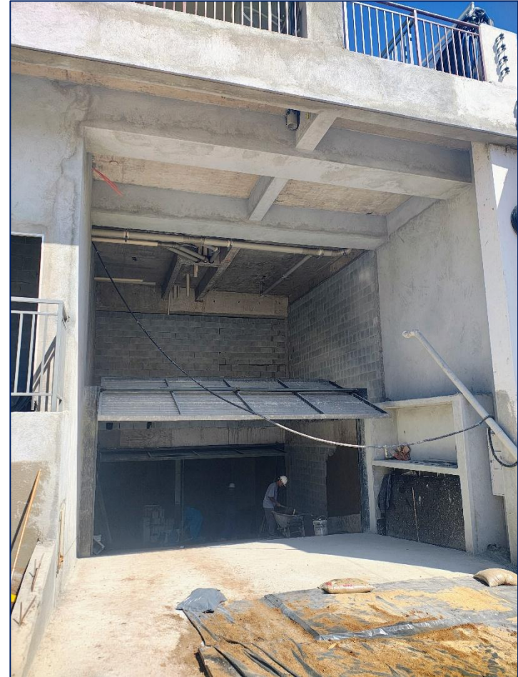
Foto 4 - Instalação do portão
