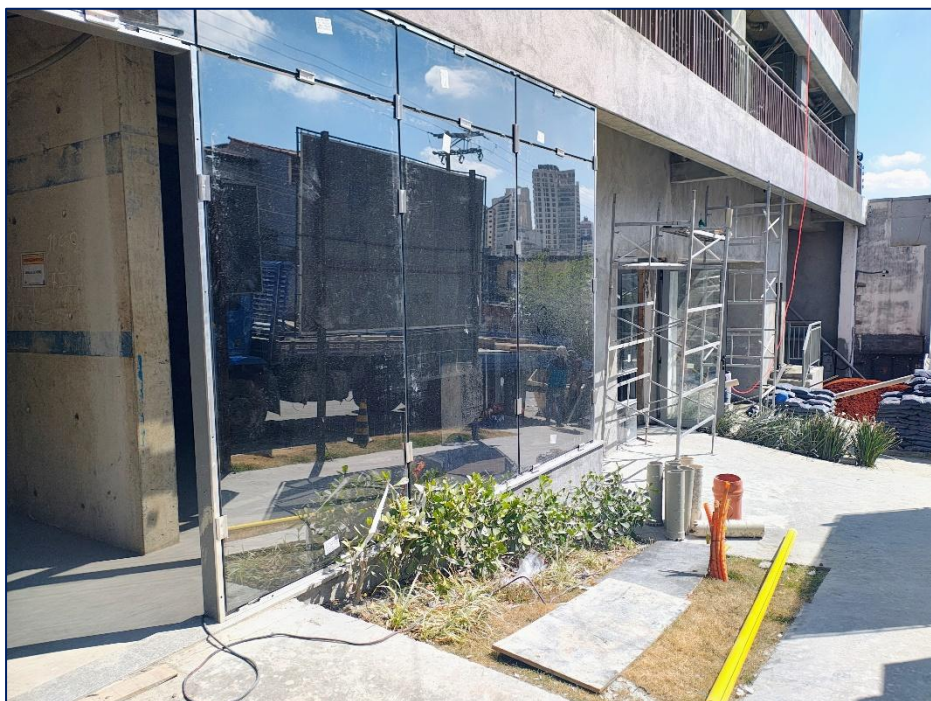
Foto 5 – Pele de vidro - Fachada
