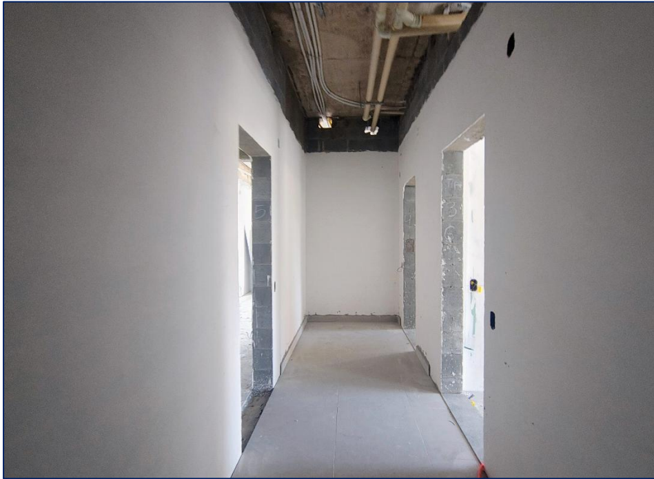
Foto 21 – Assentamento de piso – Hall andares NR
