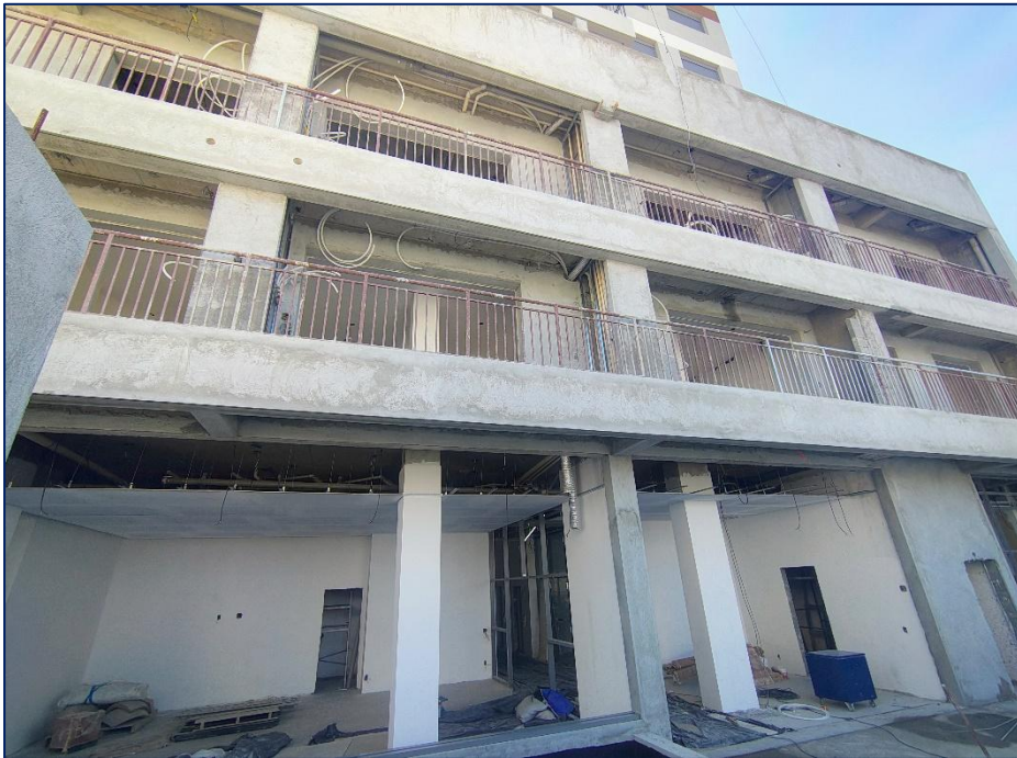
Foto 7 – Visão geral embasamento e forro de áreas comuns
