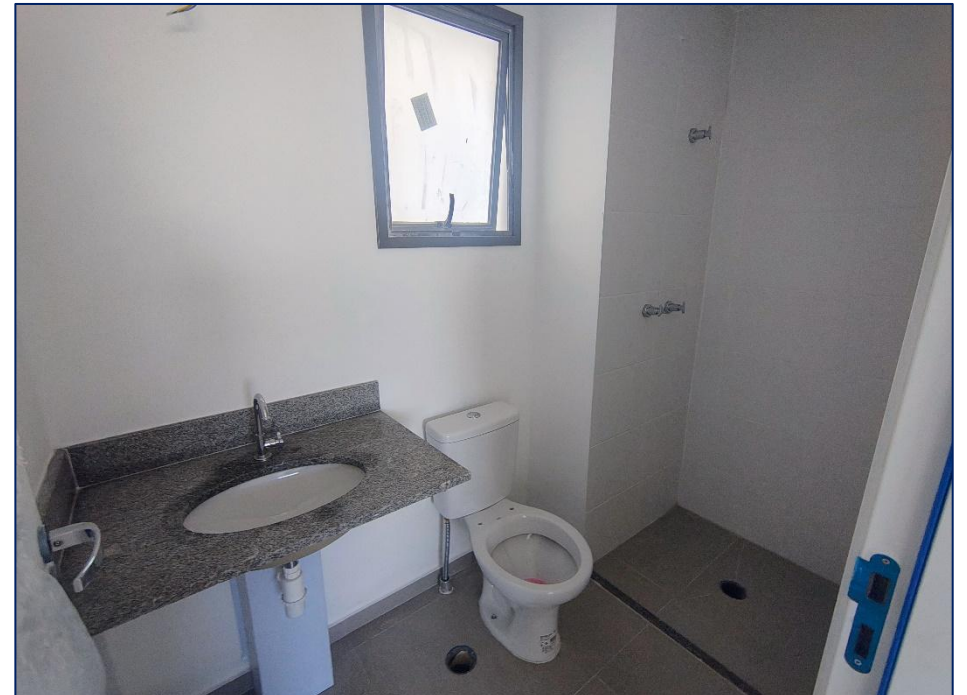
Foto 16 – Instalação de carenagem de banheiro e cozinha – 13º pavimento
