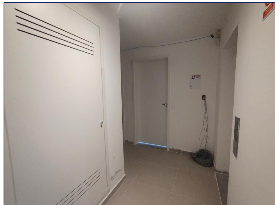
Foto 18 – Instalação de portas de shaft
