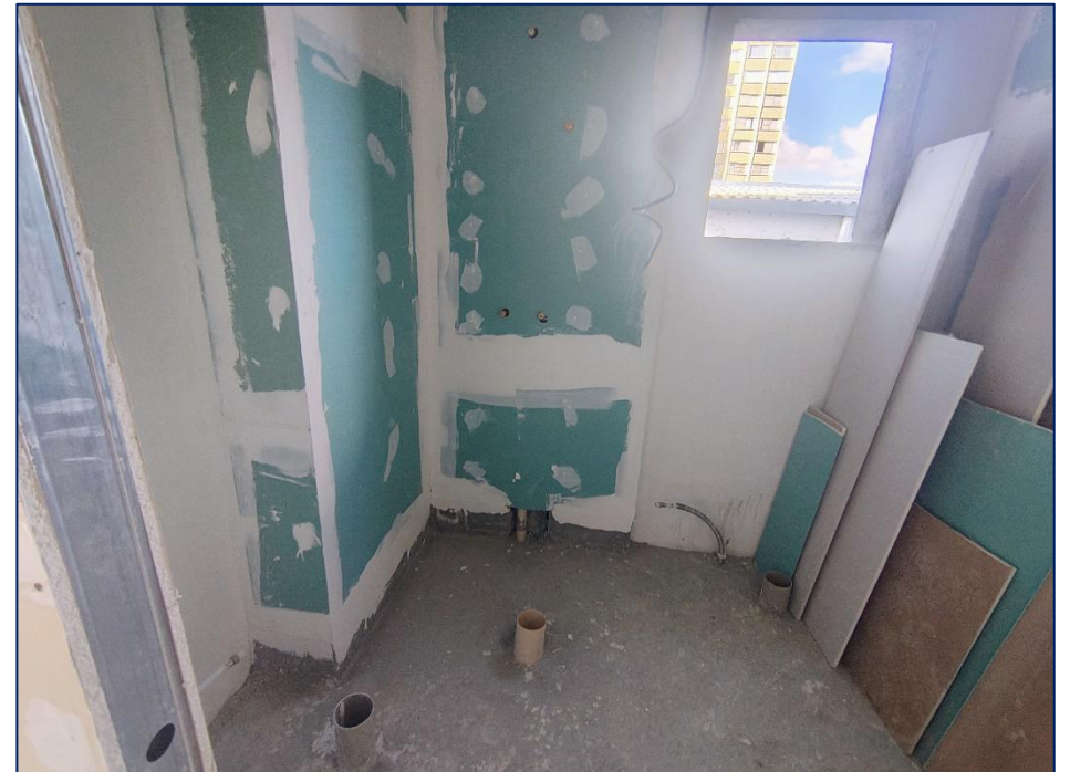
Foto 22 – Plaqueamento de shaft NR
