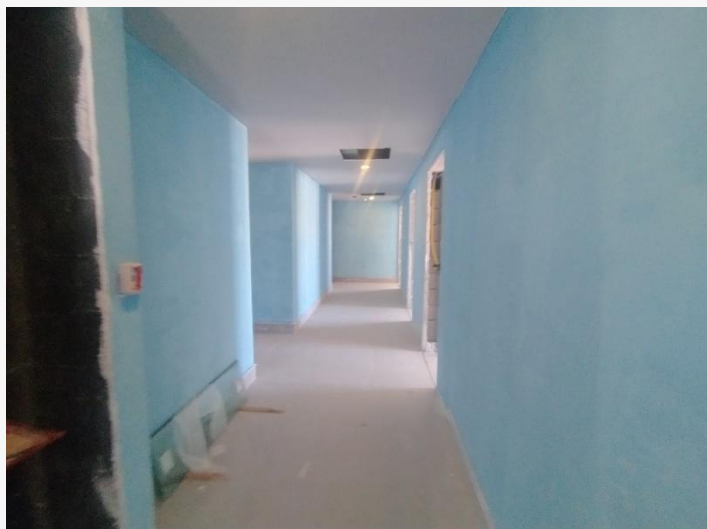
Pintura Interna – 22° Pav.
