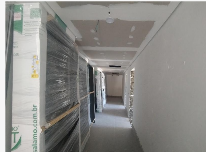
Forro de Gesso – 23° Pav.
