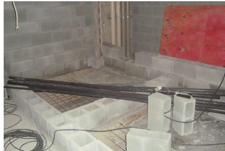
Marcação de Alvenaria – 1º Pav
