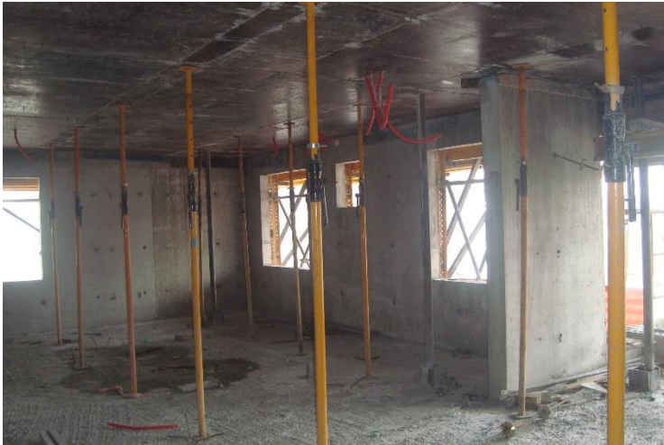
Escoramento – 6º pav
