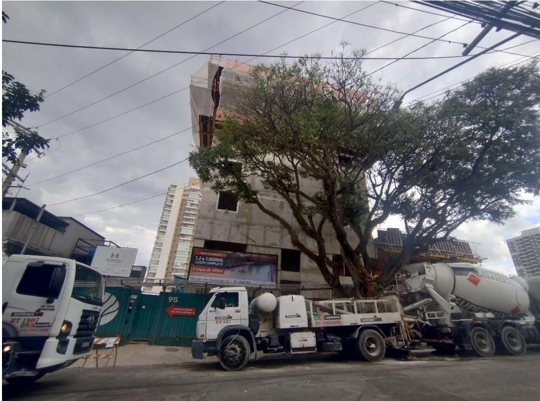
Vista Fachada Lateral
