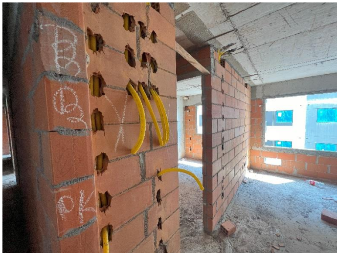
Embutidos em Alvenaria – 14º Pav
