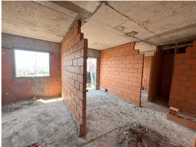
Alvenaria/ Vedação – 17º Pav
