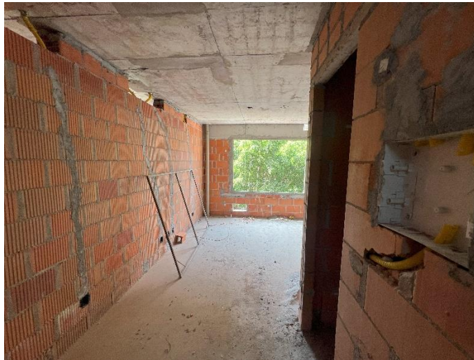
Alvenaria/ Vedação – 3º Pav
