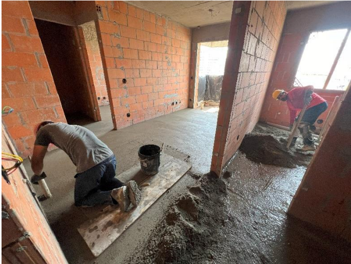
Contrapiso – 9º Pav
