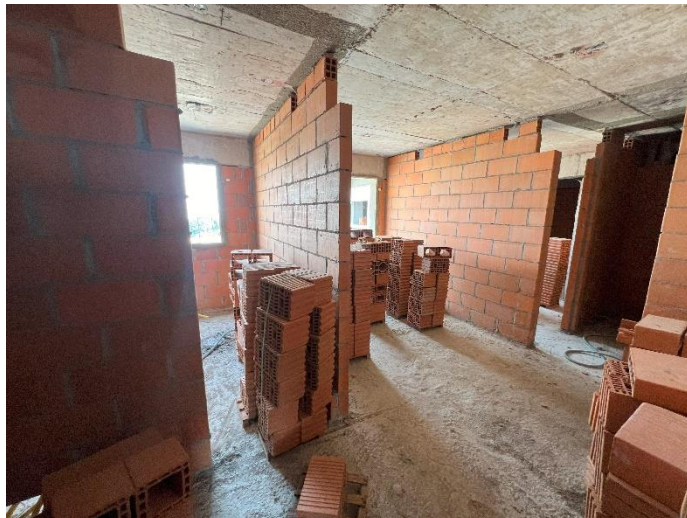
Alvenaria/ Vedação – 16º Pav
