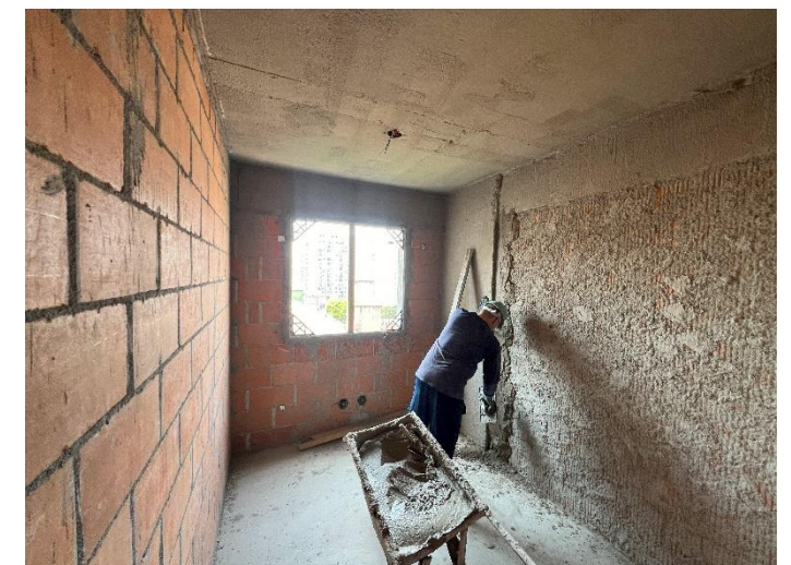
Emboço Interno – 10º Pav
