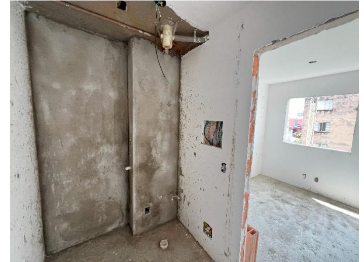
Reboco Interno – 6º Pav
