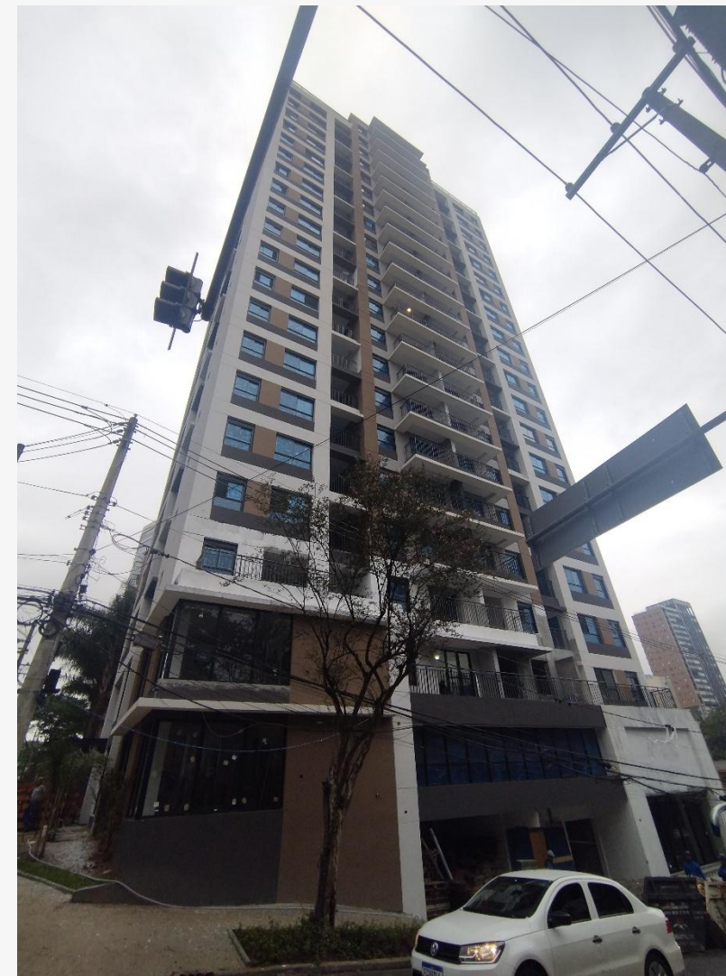
Vista da Fachada Frontal
