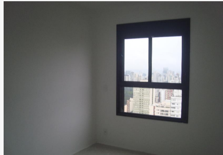
Esquadria Metálica – 11º Pav
