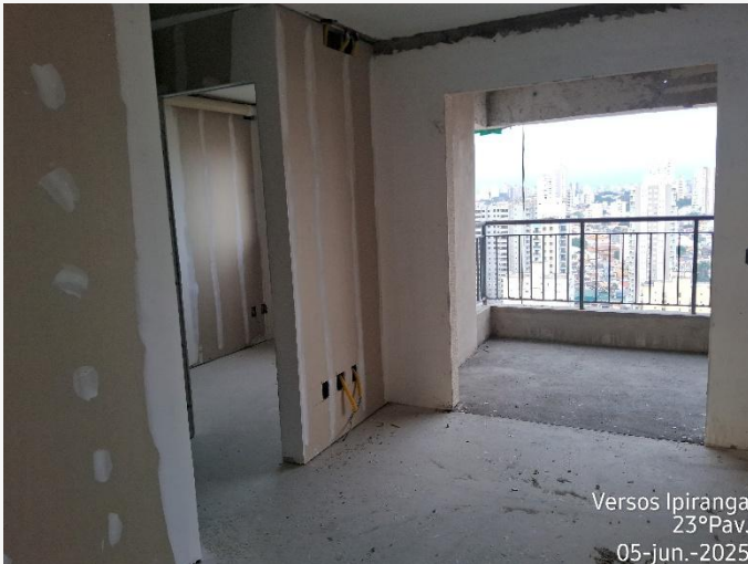
Alvenaria em Drywall – 23° Pav.
