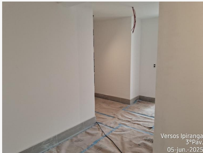
Pintura Interna – 3º Pav.
