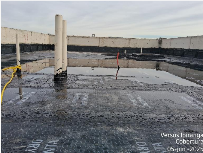
Manta Asfáltica – Cobertura
