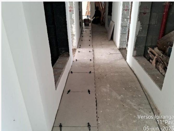
Piso Cerâmico – 11º Pav.
