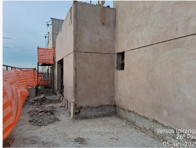
Reboco Externo – 26° Pav.
