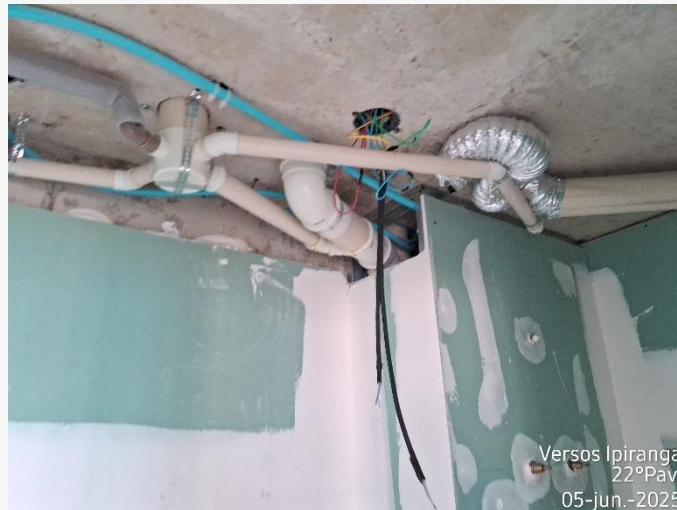
Aranha de Esgoto – 22° Pav.
