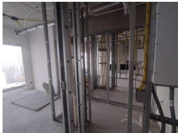
Estrutura Drywall – 15º Pav
