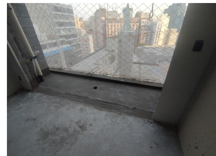
Impermeabilização – 13º Pav
