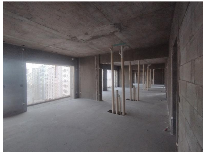
Prumadas Hidráulicas – 22º Pav
