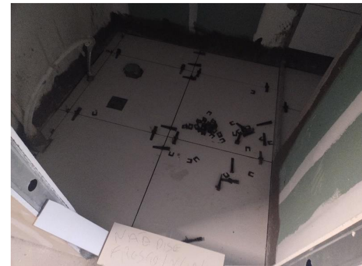
Piso em Porcelanato – 7º Pav
