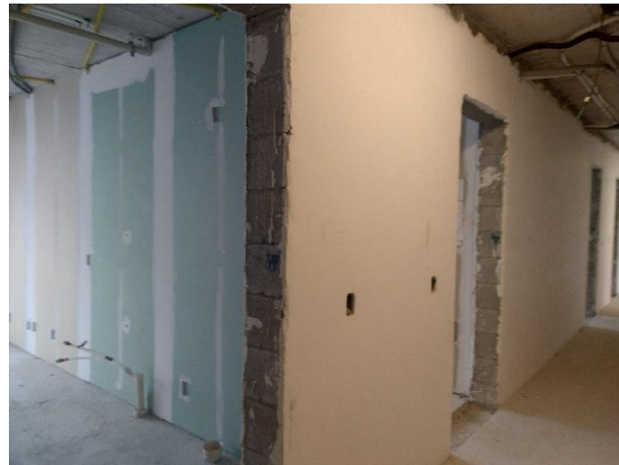
Parede Drywall – 9º Pav
