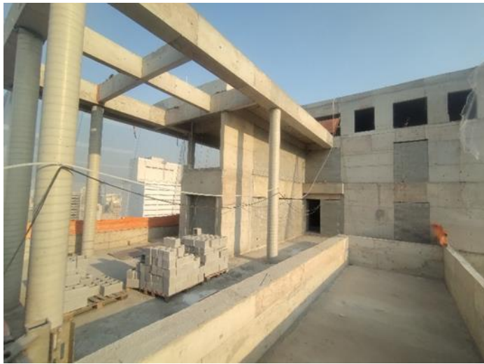
Vista Estrutura – 25º Pav
