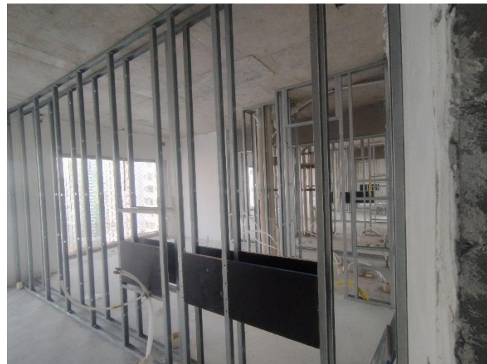
Estrutura Drywall – 19º Pav
