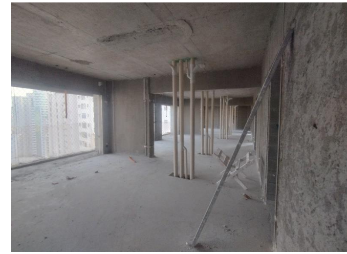
Prumadas Hidráulicas – 21º Pav
