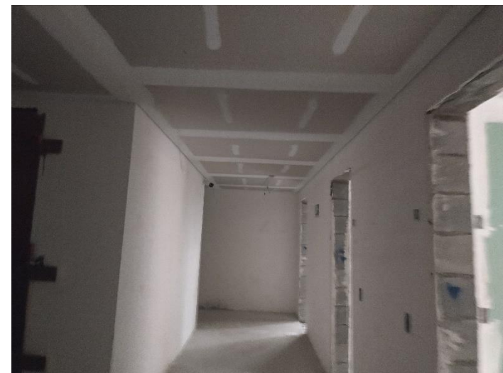
Forro em Gesso – 2º Pav
