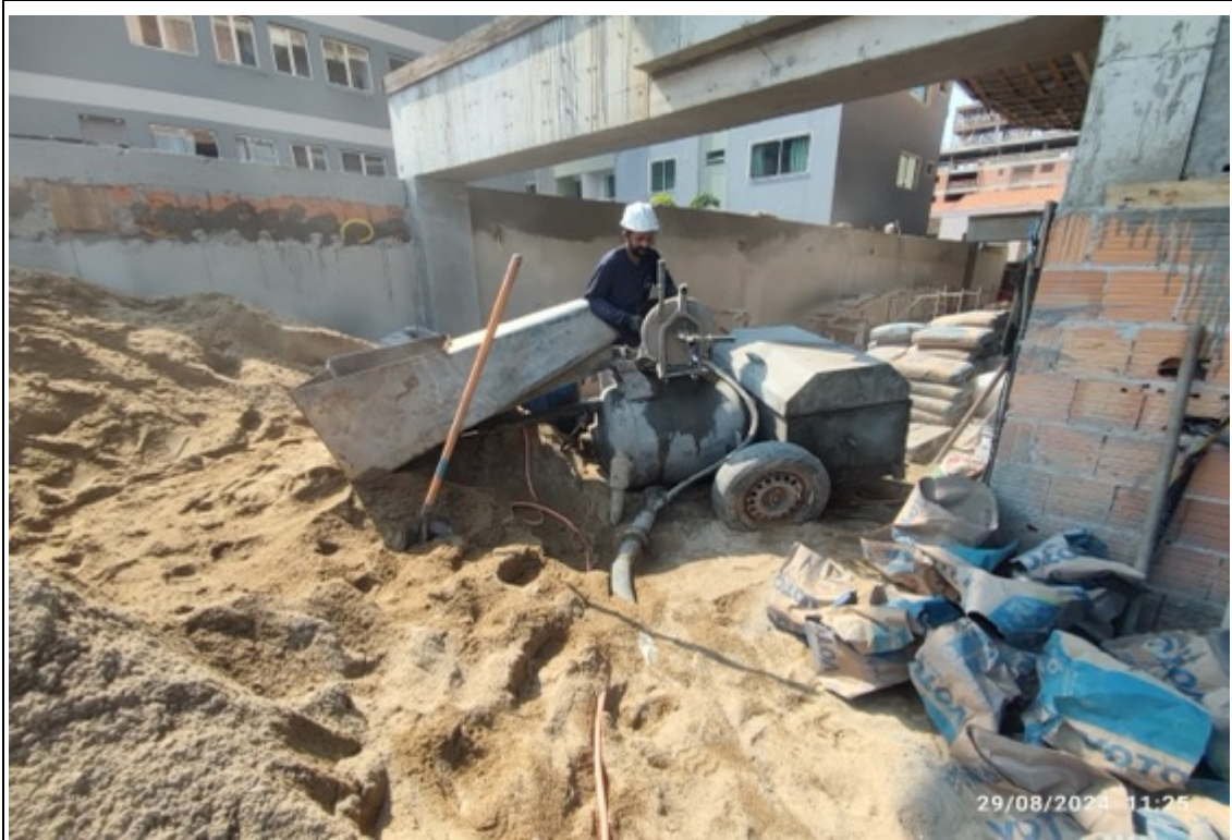
Foto 33 – Misturador de argamassa para contrapiso
