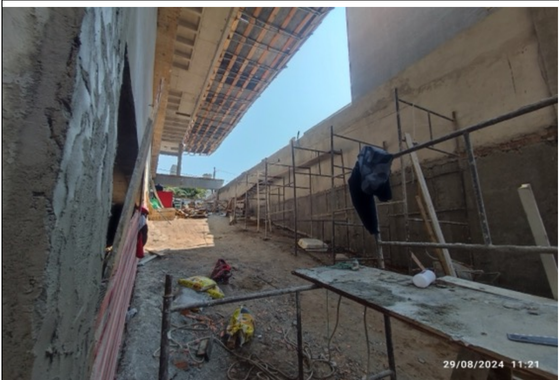
Foto 31 – Execução de reboco
