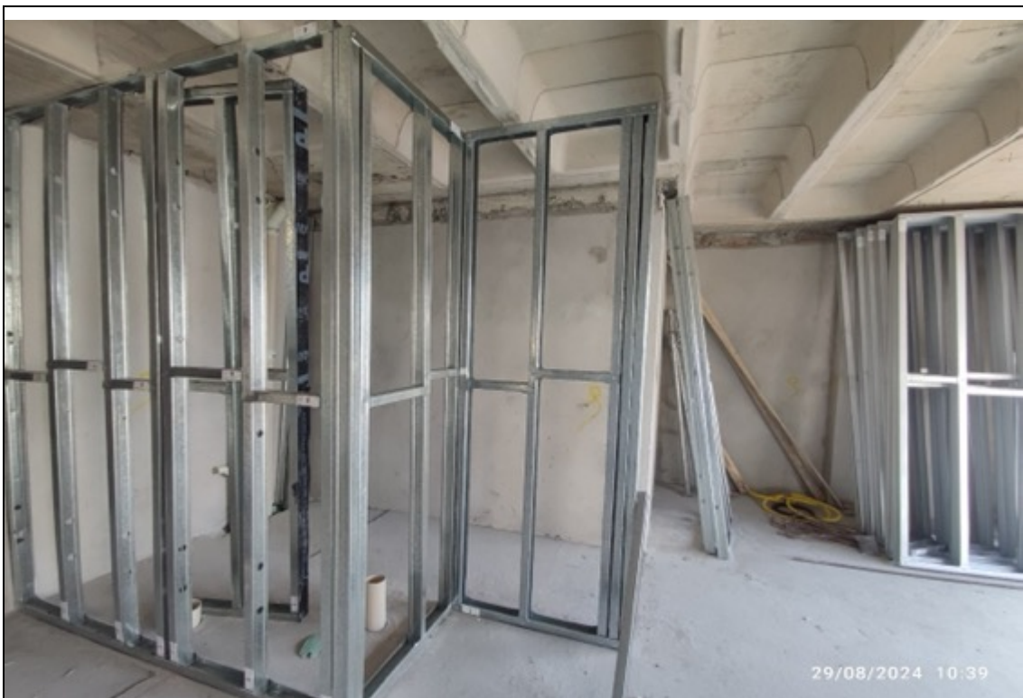
Foto 4 – Instalação de estrutura de paredes de dry wall
