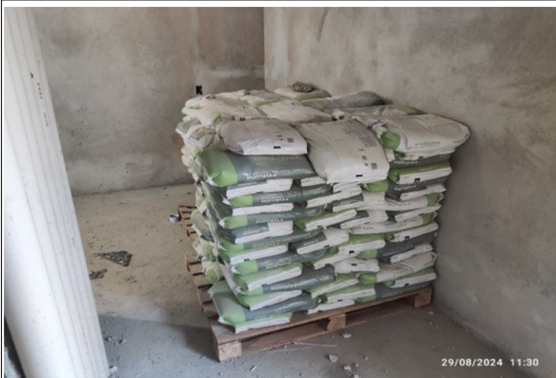
Foto 35 – Estoque de argamassa
