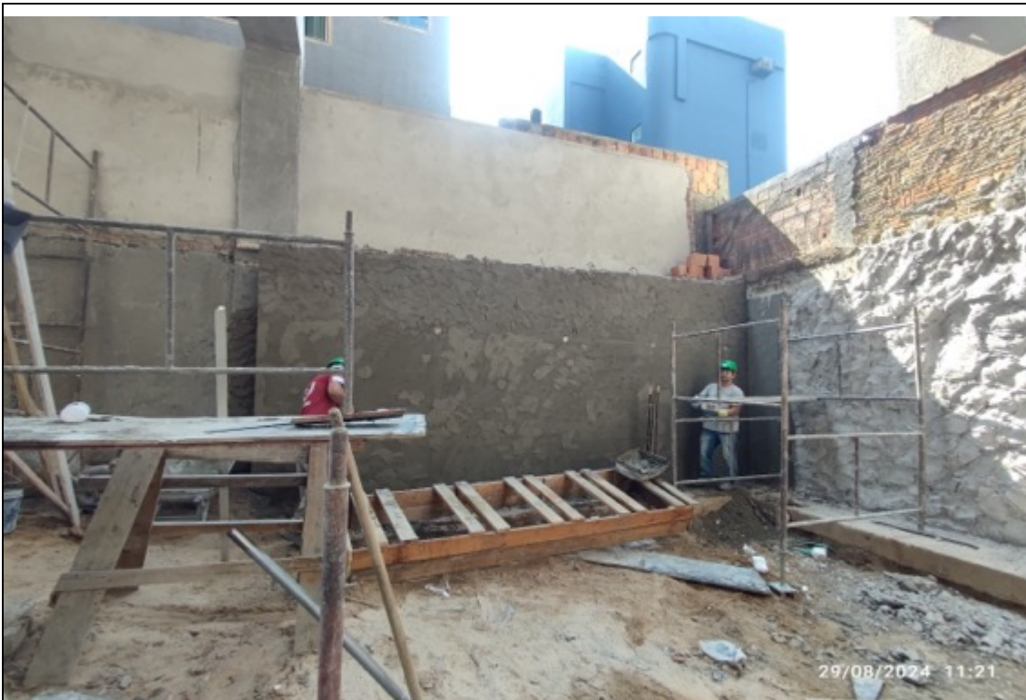
Foto 30 – Execução de reboco dos muros externos
