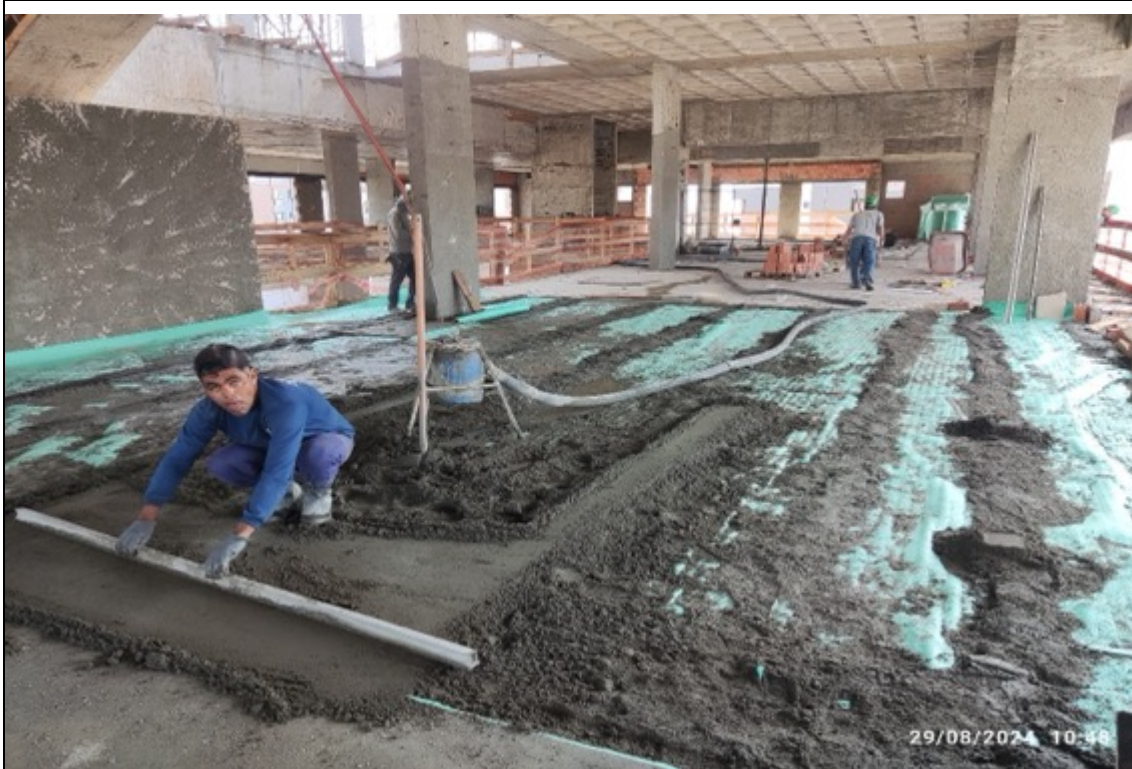
Foto 11 – Execução de contrapiso
