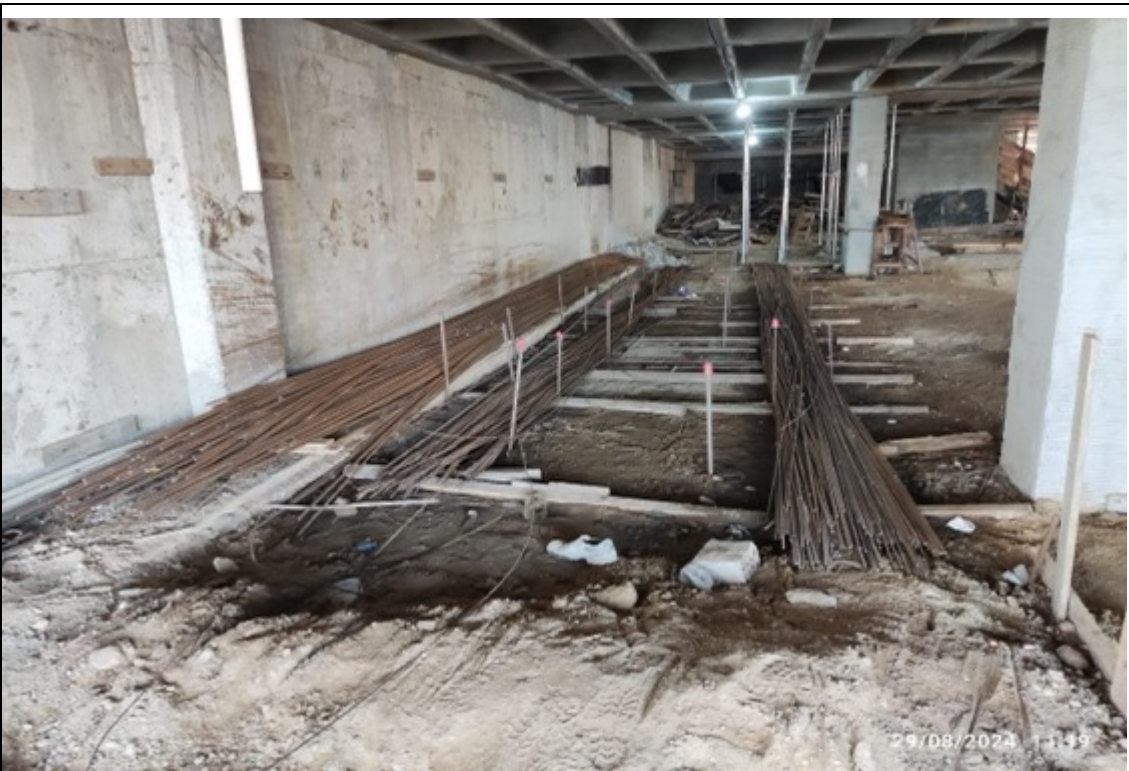
Foto 28 – Estoque de aço
