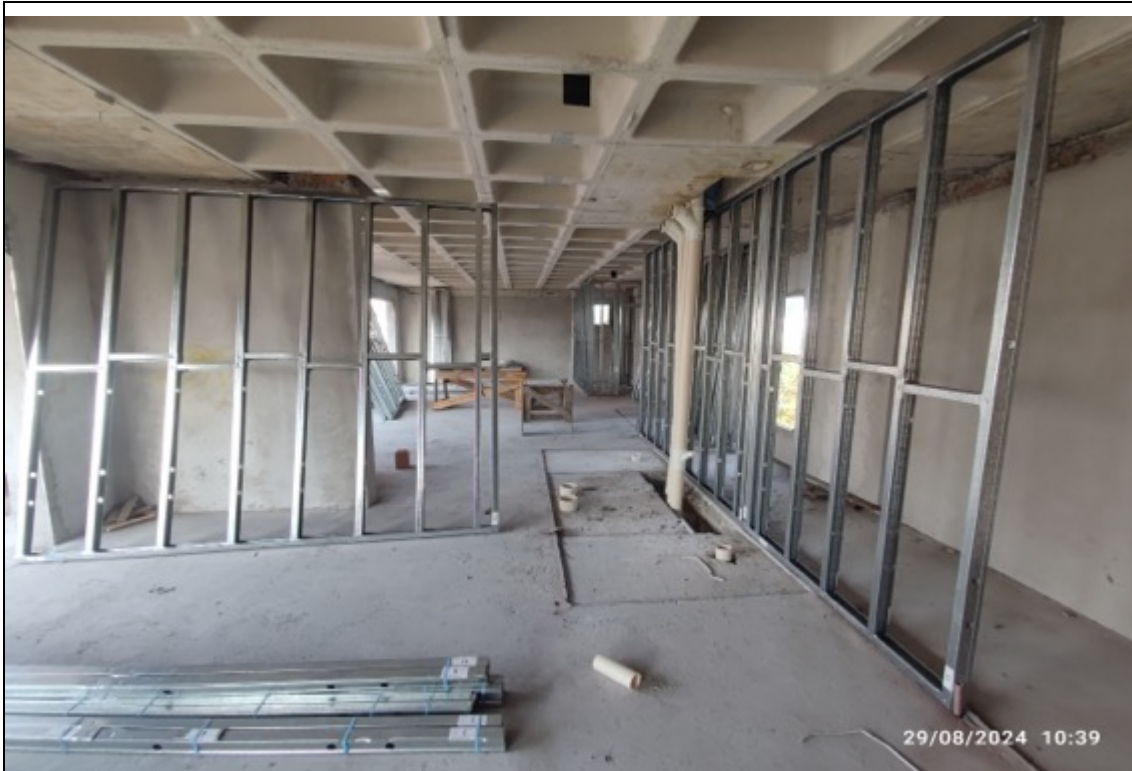
Foto 5 – Instalação de estrutura de paredes de dry wall
