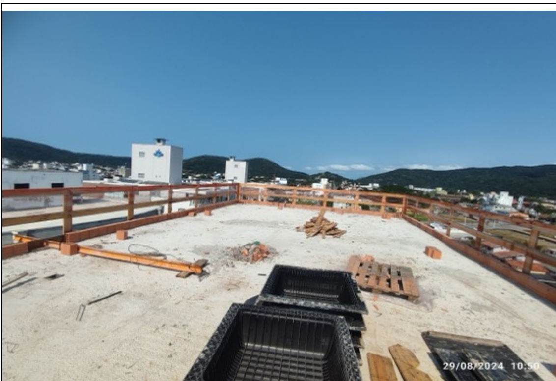
Foto 12 – Proteção periférica da cobertura
