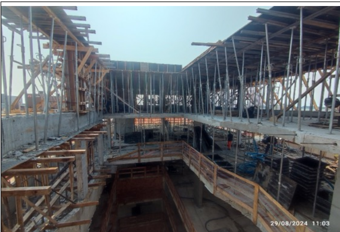
Foto 18 – Escoramento da laje da cobertura
