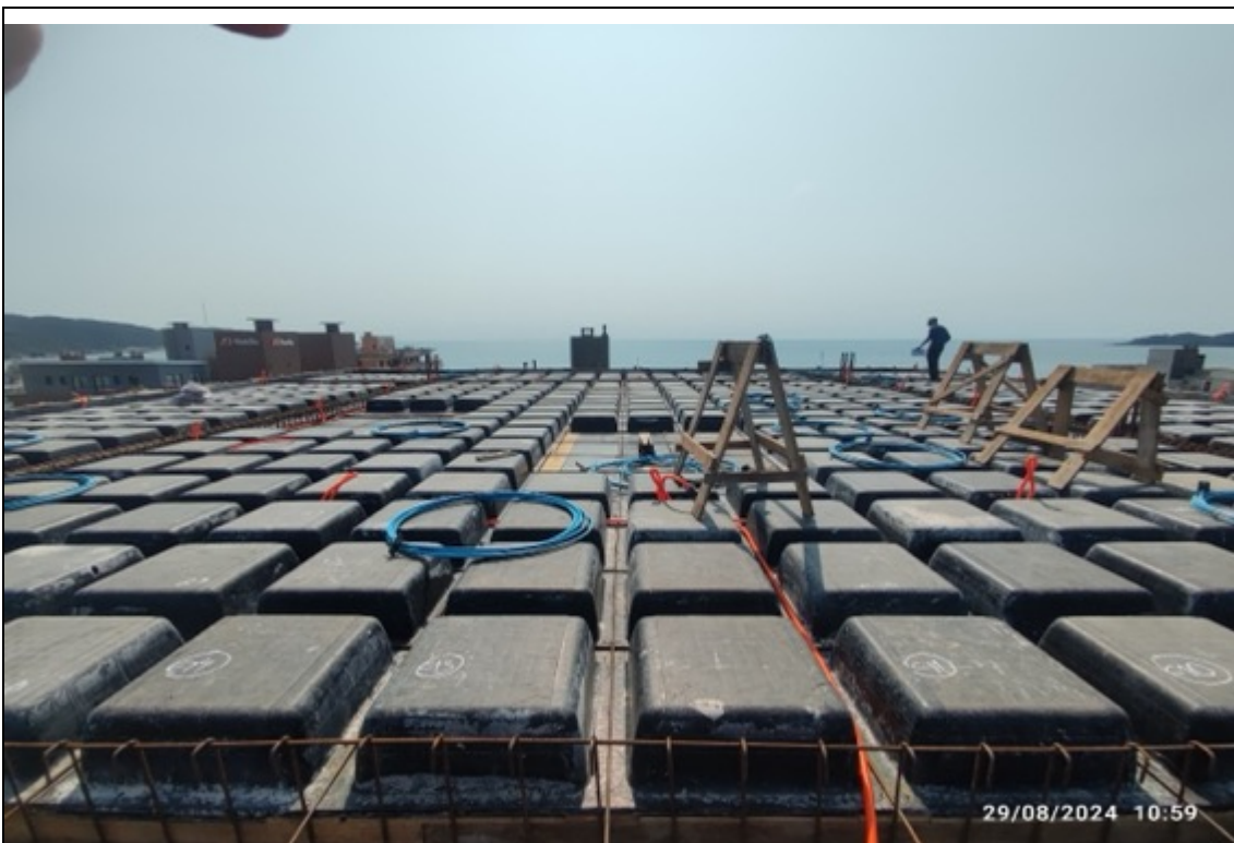
Foto 16 – Laje do heliponto
