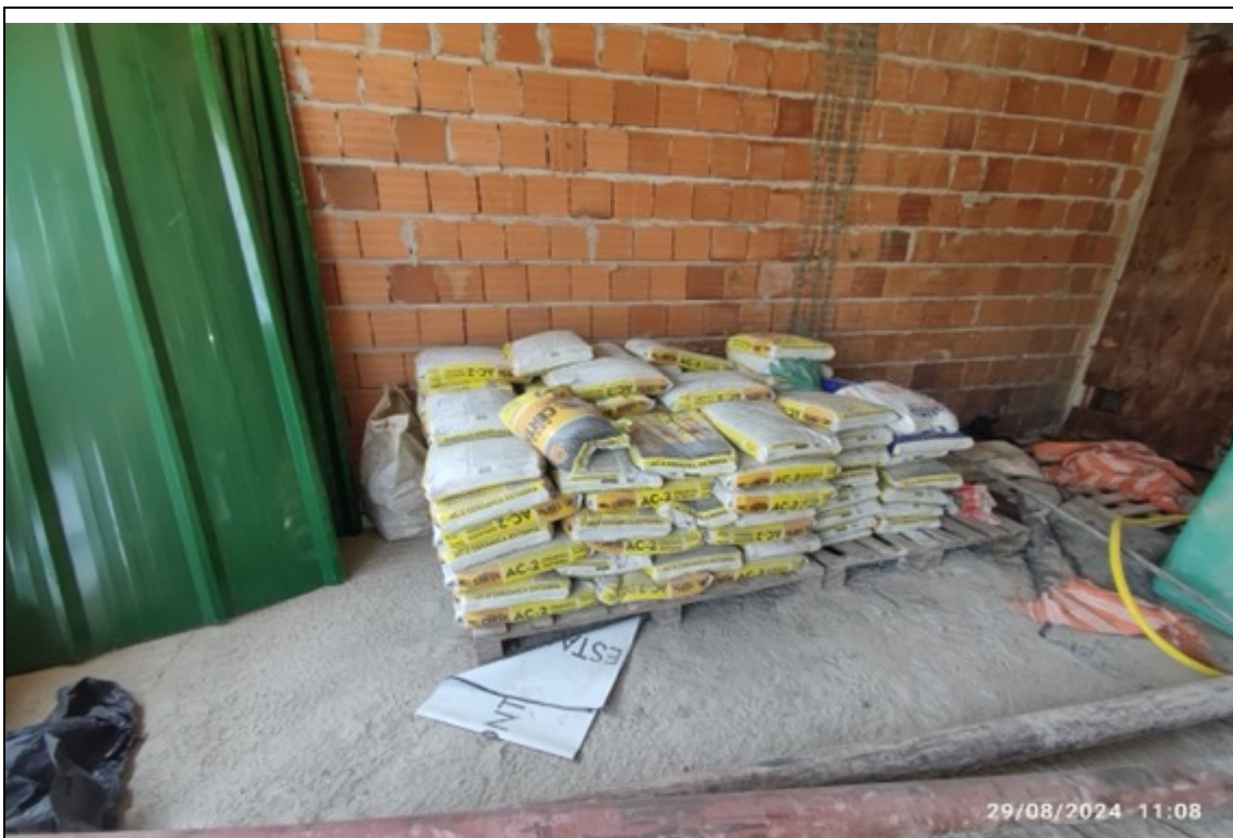
Foto 20 – Estoque de argamassa
