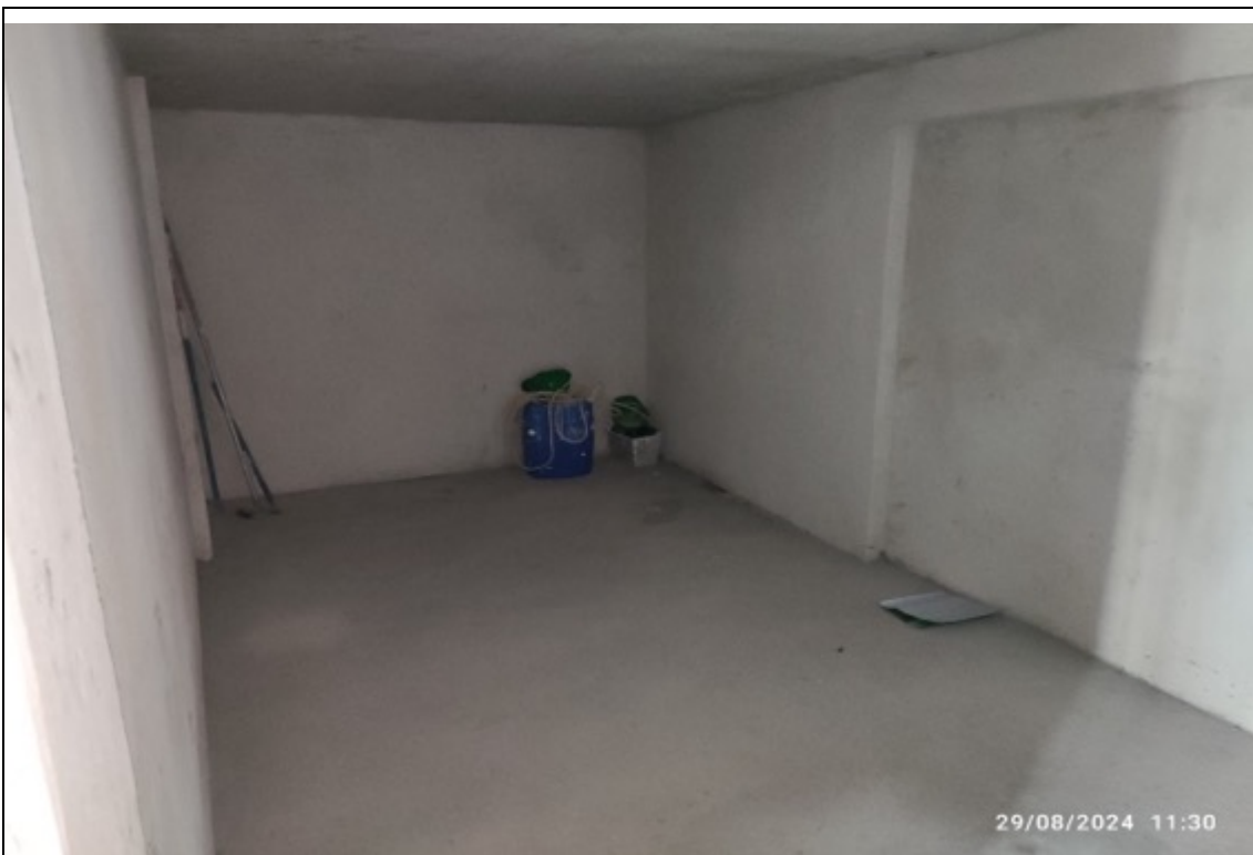
Foto 34 – Reboco e contrapiso do térreo
