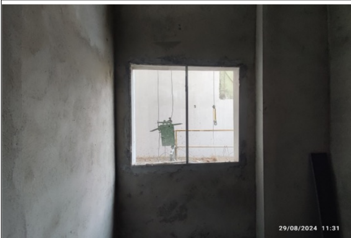
Foto 37 – Reboco interno térreo
