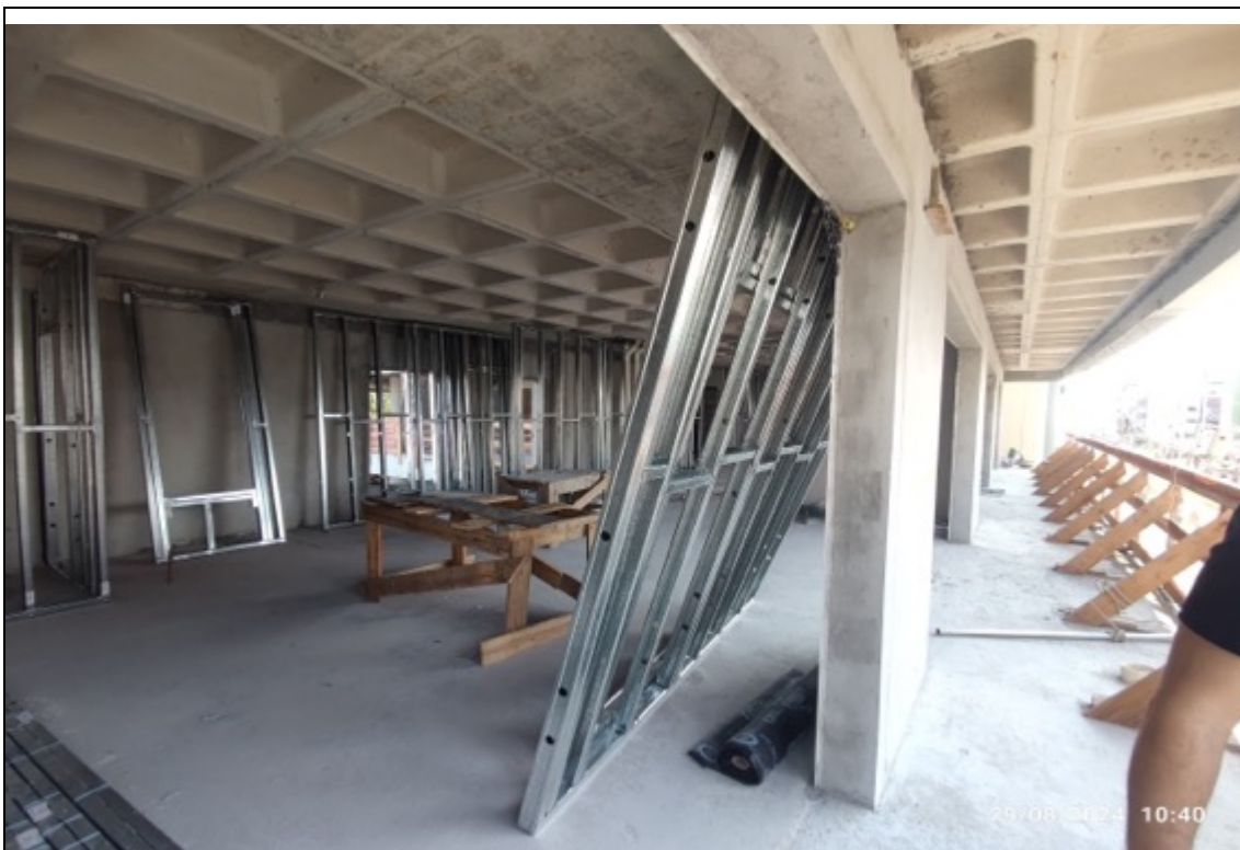
Foto 8 – Instalação de estrutura de paredes de dry wall
