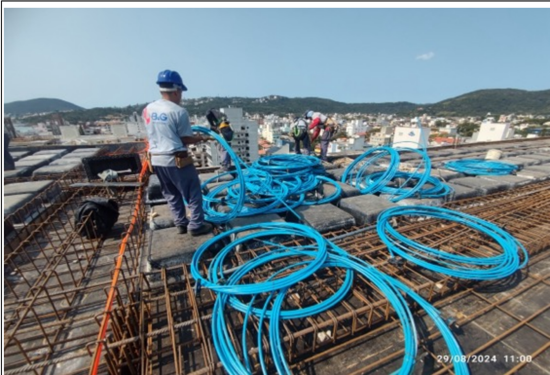
Foto 17 – Execução de laje do heliponto
