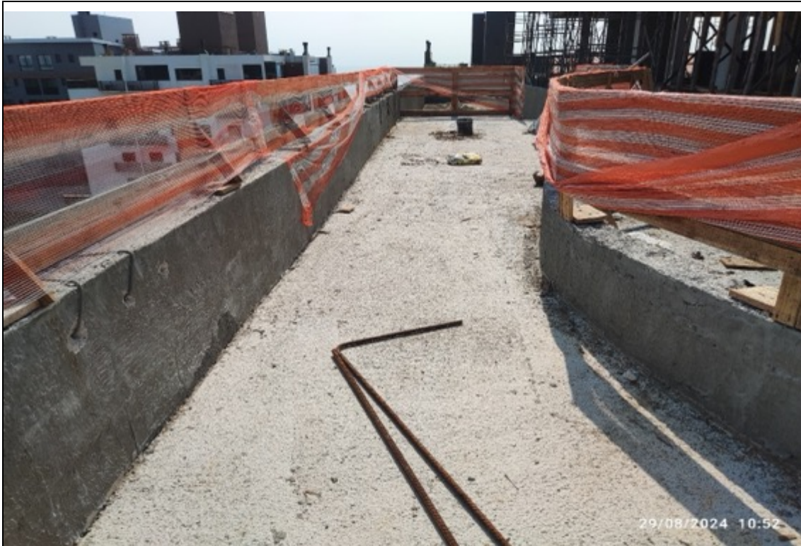
Foto 13 – Proteção periférica da piscina
