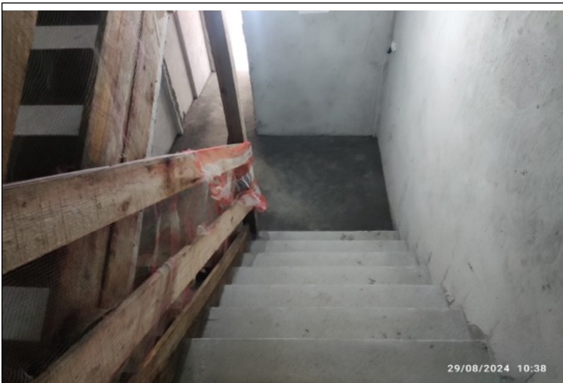
Foto 2 – Escadas com proteção e contrapiso
