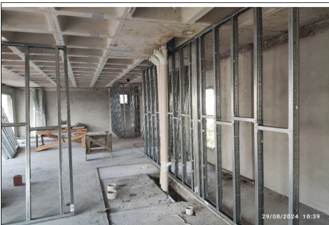
Foto 6 – Instalação de estrutura de paredes de dry wall
