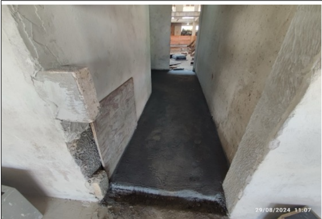
Foto 19 – Impermeabilização no contrapiso do térreo
