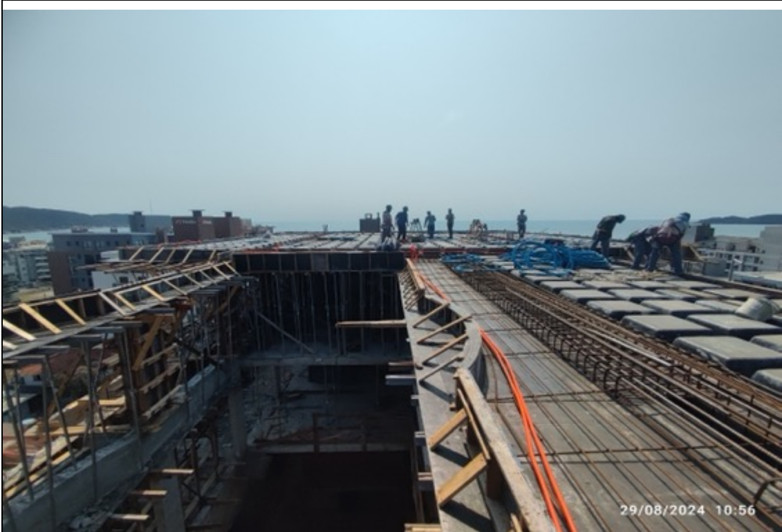
Foto 15 – Execução da laje do heliponto
