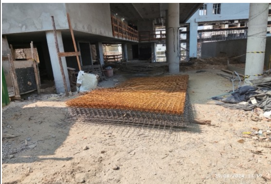
Foto 27 – Estoque de tela soldada
