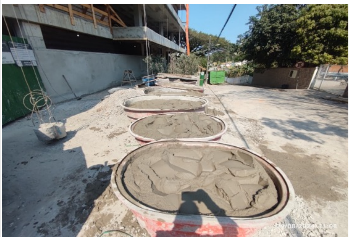
Foto 21 – Entrega de massa para fachada
