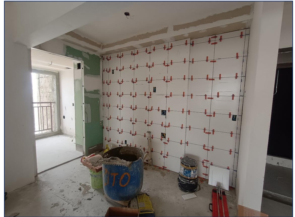
Foto 12 - Revestimento cerâmico - 5º pav
