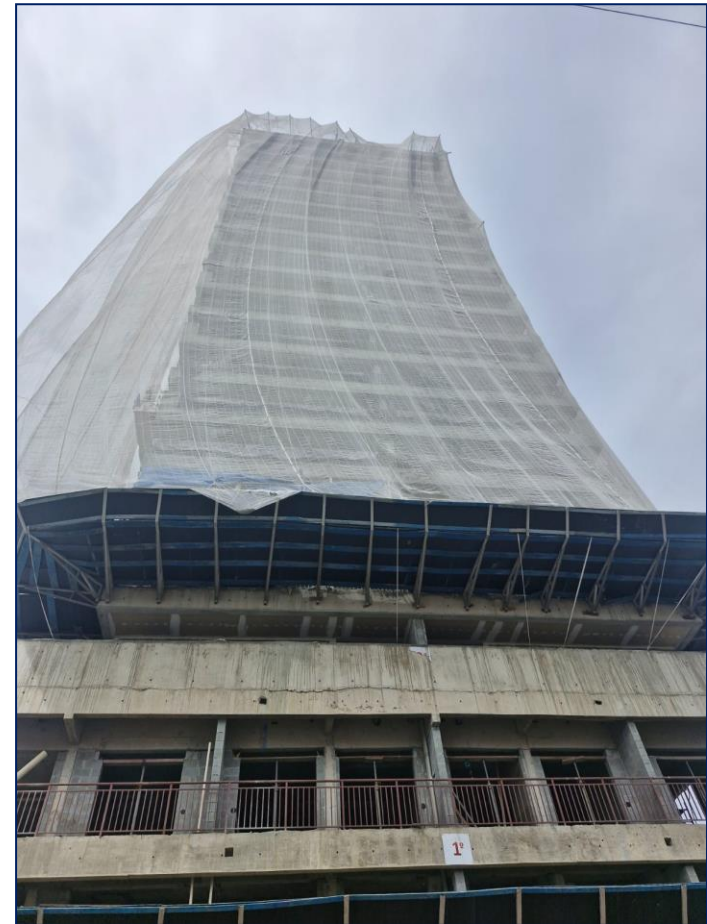
Foto 2 - Visão geral torre
