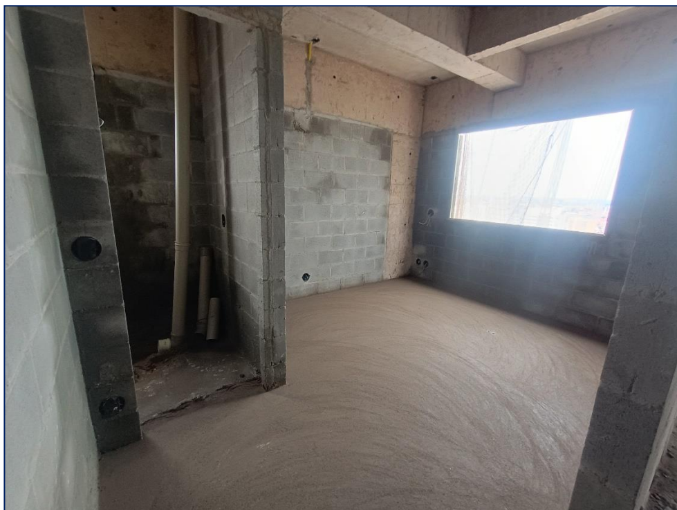
Foto 5 - Execução de contrapiso - 21º pav
