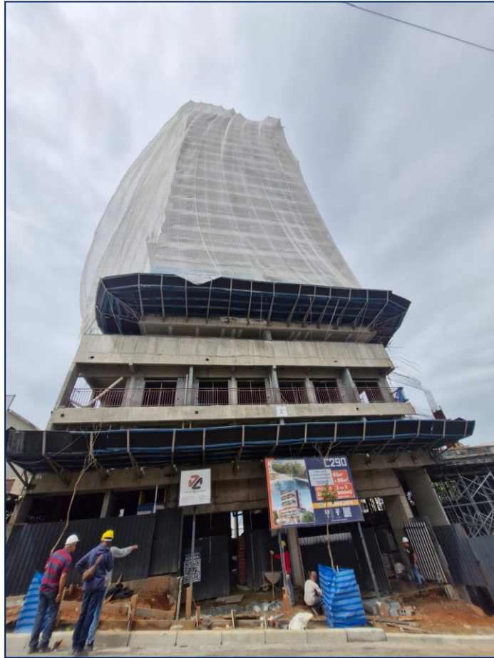
Foto 1 - Visão geral frente obra
