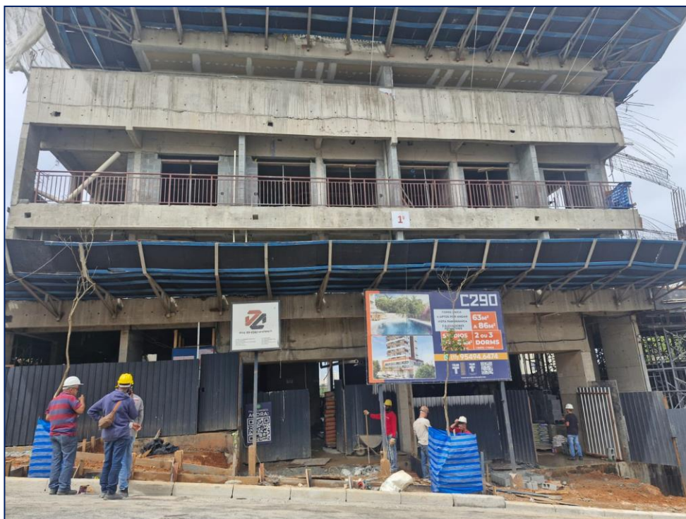
Foto 3 - Visão geral frente obra
