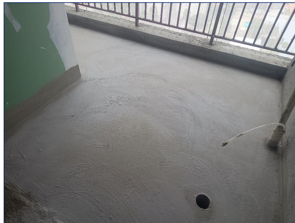
Foto 10 - Impermeabilização argamassa polimérica - 9º pav
