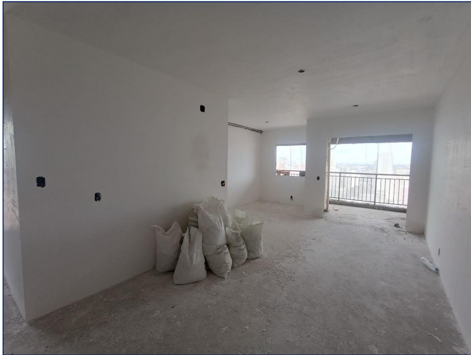
Foto 11 - Forro - 7º pav
