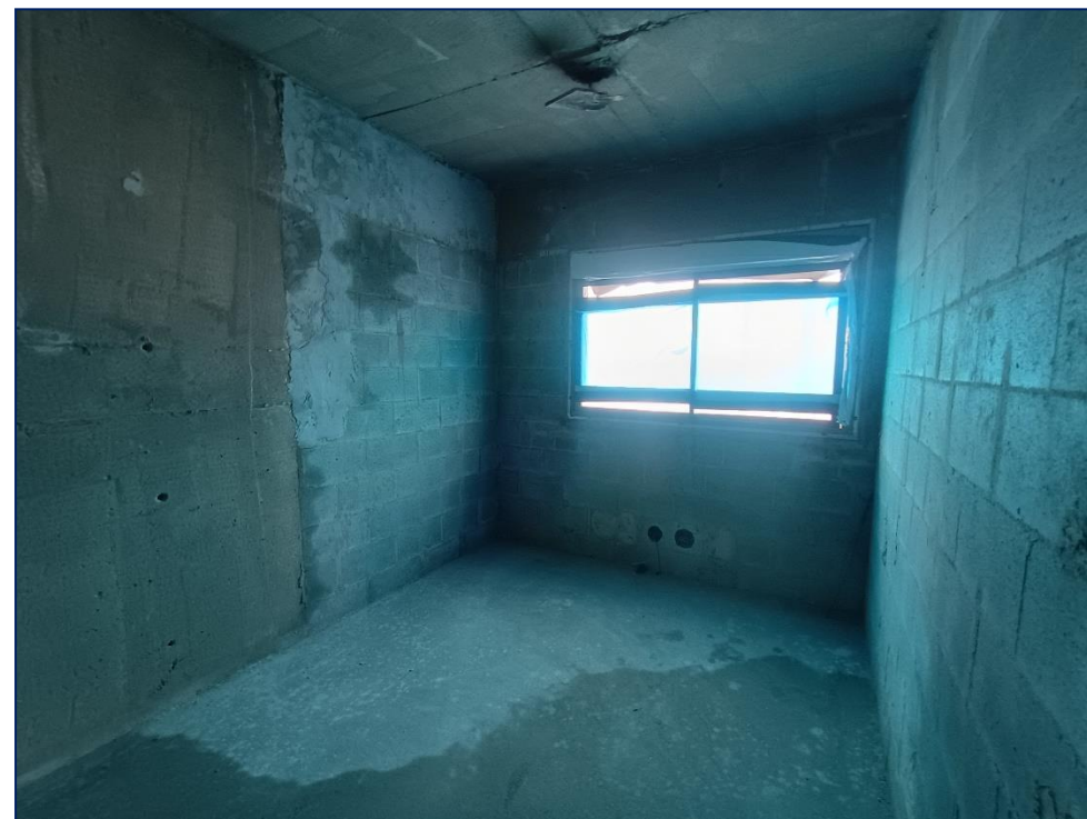
Foto 6 - Caixilho - 20º pav
