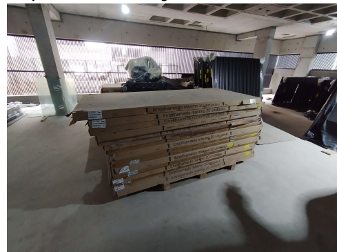
Foto 6 - Estoque de Portas Corta fogo
