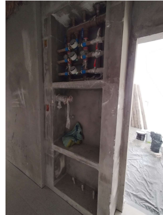
Foto 14 - Prumada do andar
