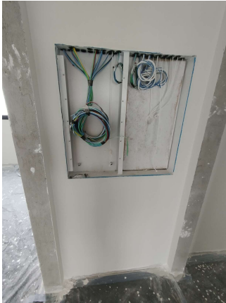
Foto 13 - Aguardando montagem dos quadros
