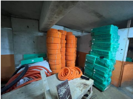
Tubulação elétrica laje
