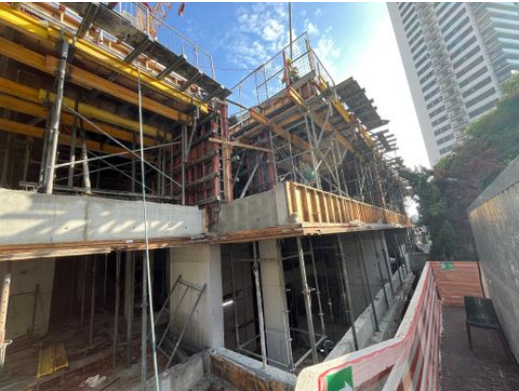
Vista geral da estrutura do empreendimento
