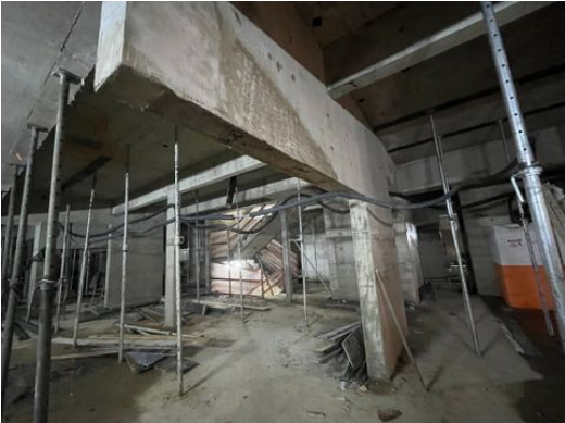
Estrutura do 1.º subsolo
