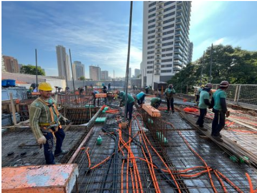
Ajustes finais da armação para concretagem da laje piso do 1.º andar
