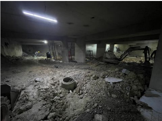
Trecho do 3.º subsolo com piso a ser executado
