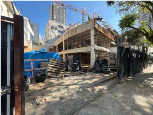
Vista geral da estrutura do empreendimento
