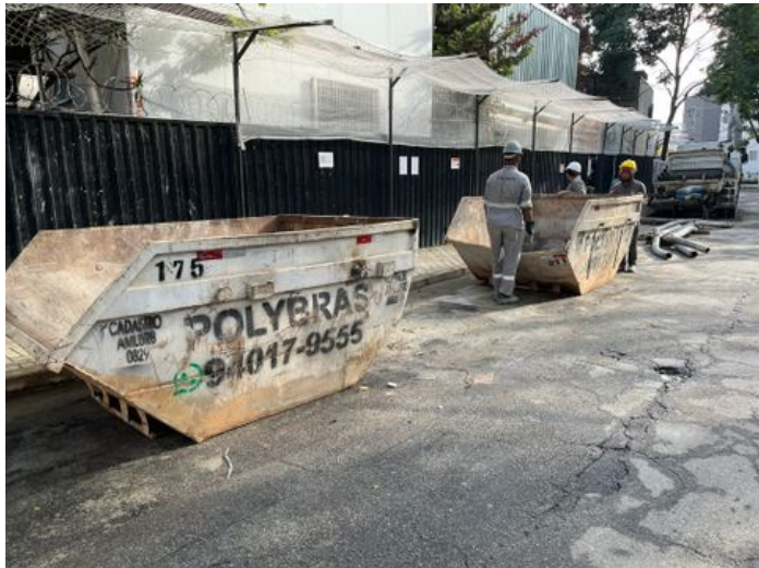
Caçambas na frente da obra
