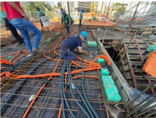
Últimos ajustes das instalações elétricas embutidas na laje piso do 1.º andar
