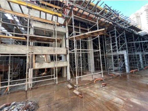
Estrutura do Térreo
