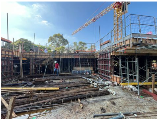
Laje do mezanino
