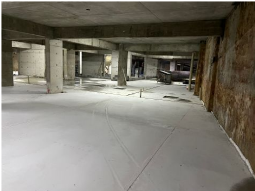
3.º subsolo com piso parcialmente executado
