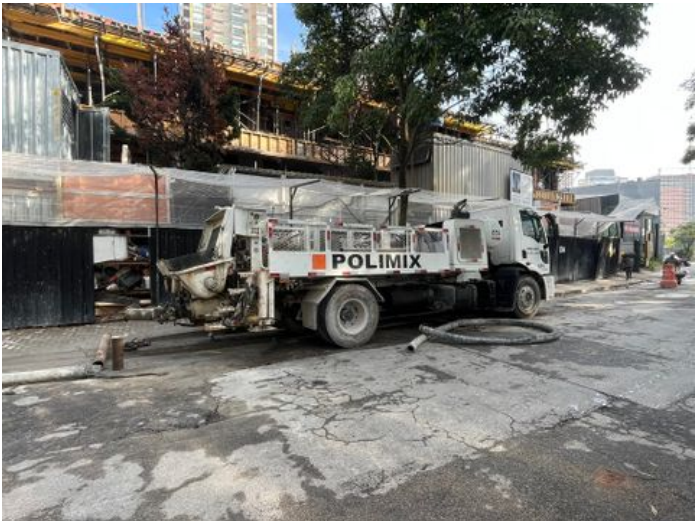
Bomba de concreto para concretagem de laje piso do 1.º andar
