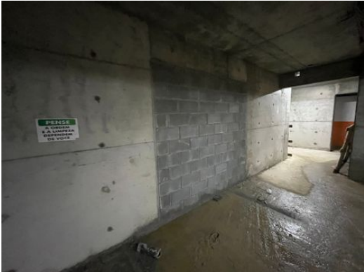
Alvenaria executada no 2.º subsolo
