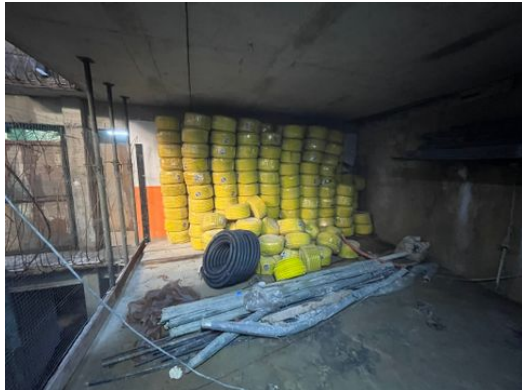
Tubulação elétrica alvenaria
