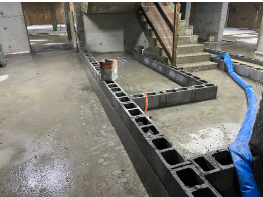
Marcação de alvenaria no 3.º subsolo
