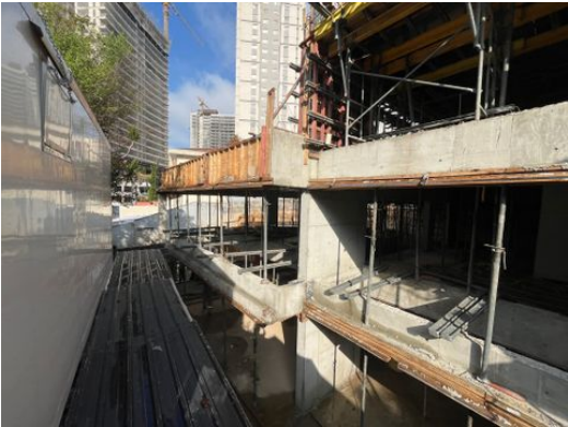
Vista geral da estrutura do empreendimento
