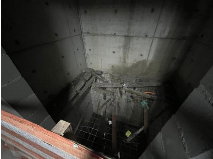
Poço elevador protegido
