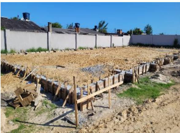
05 Execução de Fundações - Quadra de Tênis.
