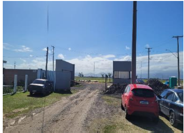
02 Fachada - Acesso ao Empreendimento.
