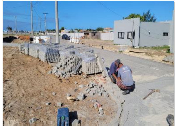
04 Execução de Pavimentação.
