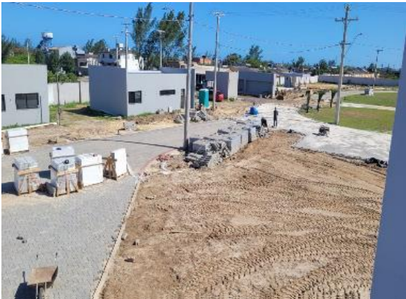
03 Execução de Pavimentação.
