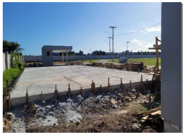
06 Execução de Piso - Quadra de Paddle.
