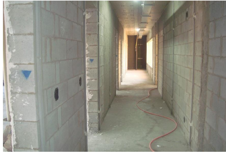
Alvenaria Vedação – 17º Pav
