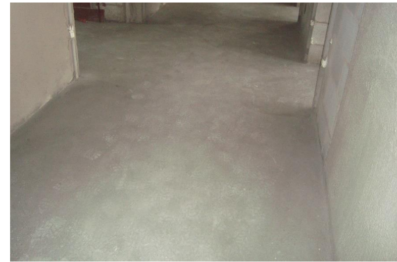
Contrapiso – 18º Pav
