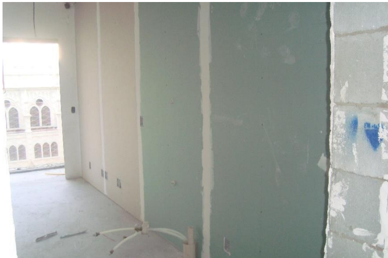
Forro de Gesso – 5º Pav
