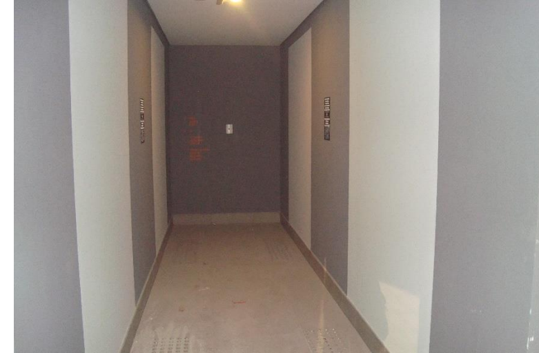
Pintura Interna – 4º Pav
