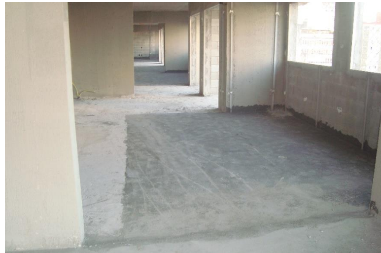
Impermeabilização – 18º Pav
