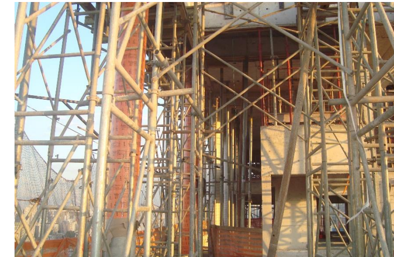
Escoramento – 25º Pav
