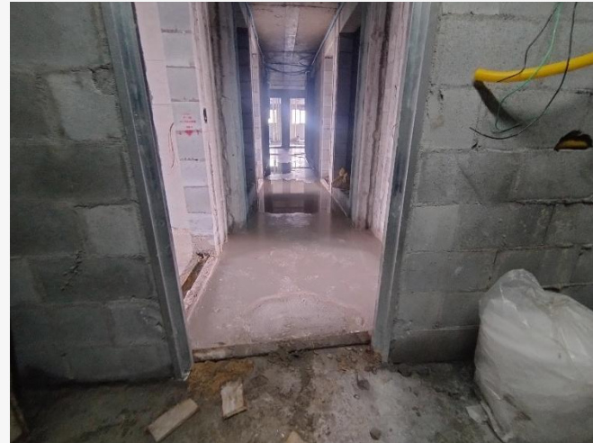
Contrapiso Autonivelante – 20° Pav
