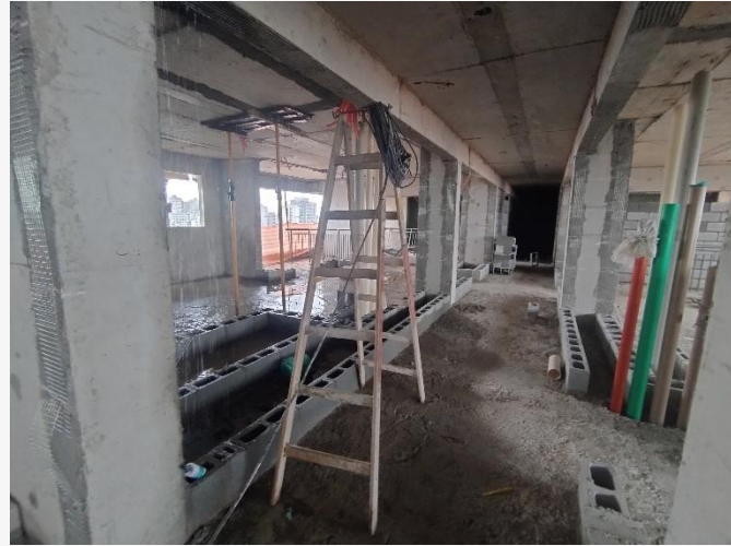
Marcação de Alvenaria – 25° Pav
