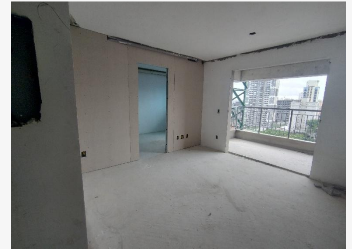
Alvenaria Drywall – 12º Pav
