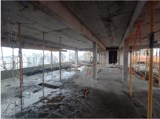
Vista Estrutura – 26° Pav
