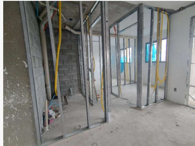
Estrutura Drywall – 15º pav
