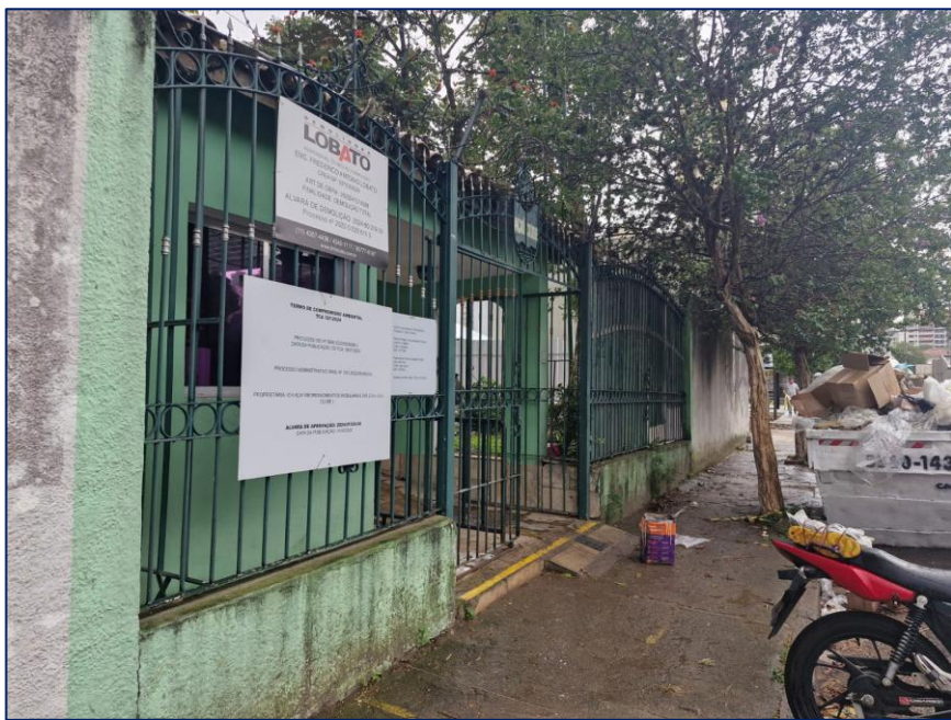
Foto 1 – Visão geral frente obra
