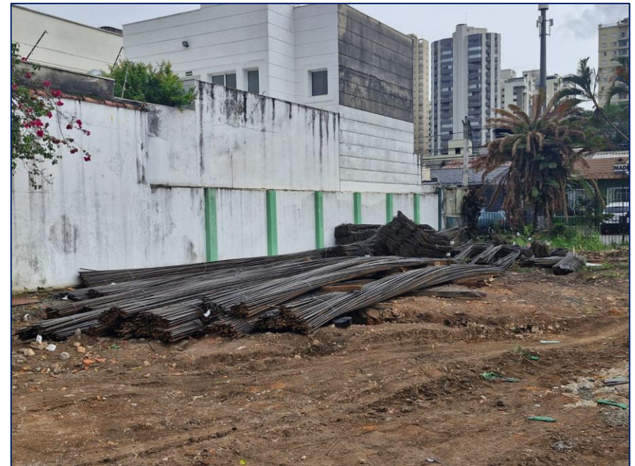
Foto 4 – Material para fundação - aço
