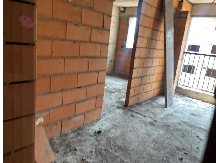
Alvenaria/ Vedação – 8º Pav
