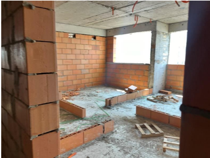
Alvenaria/ Vedação – 9º Pav
