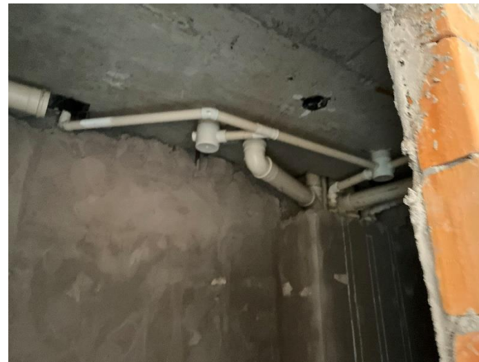
Ramais de Esgoto – 5º Pav
