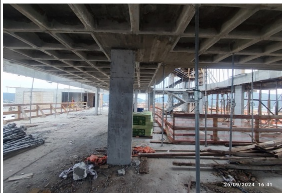
Foto 45 – Limpeza da laje após retirada do escoramento
