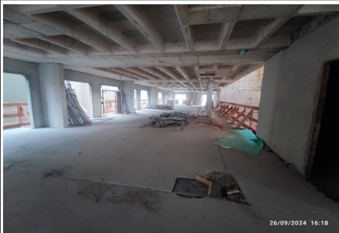
Foto 20 – Limpeza e marcação para estruturas das paredes das suítes
