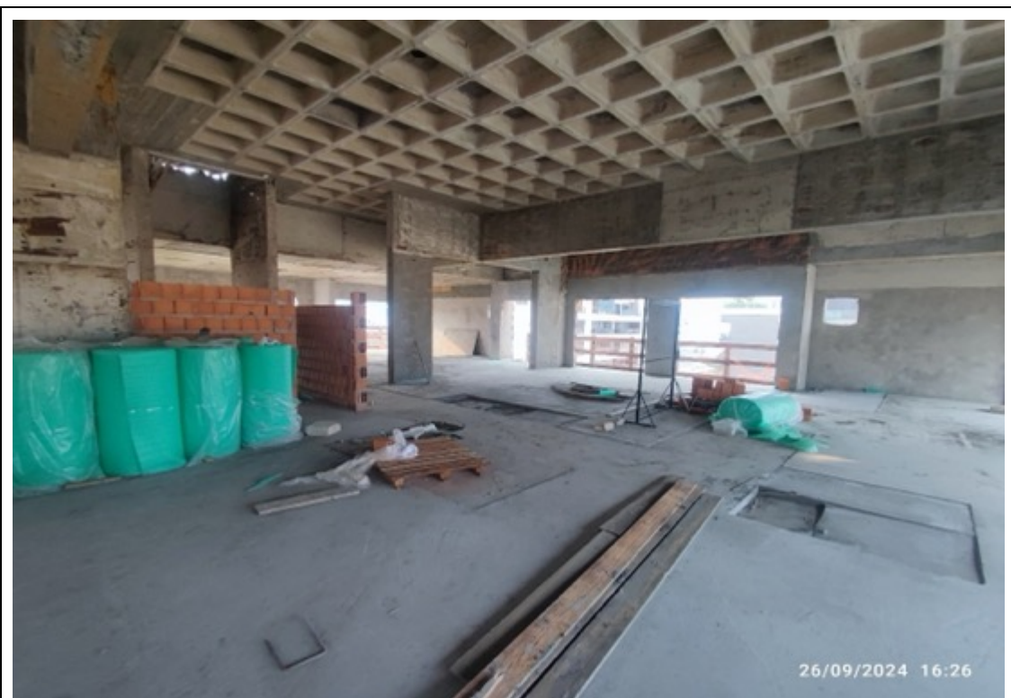
Foto 37 – Estoque de manta acústica da laje
