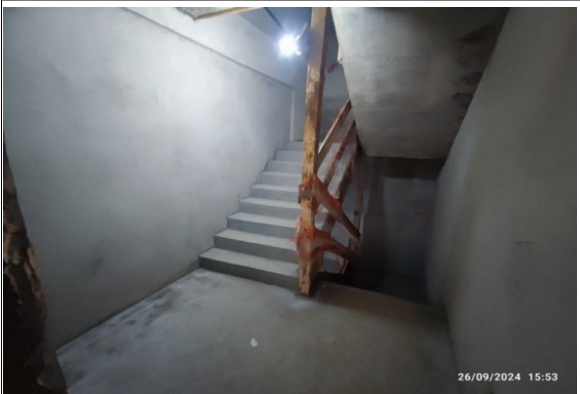
Foto 6 – Escada com contrapiso executado
