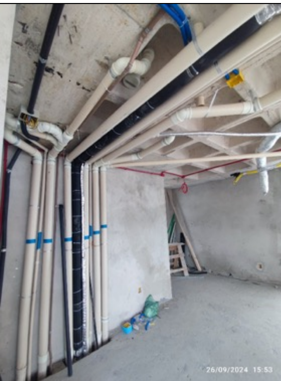
Foto 5 – Fechamento de desvios hidráulicos na recepção
