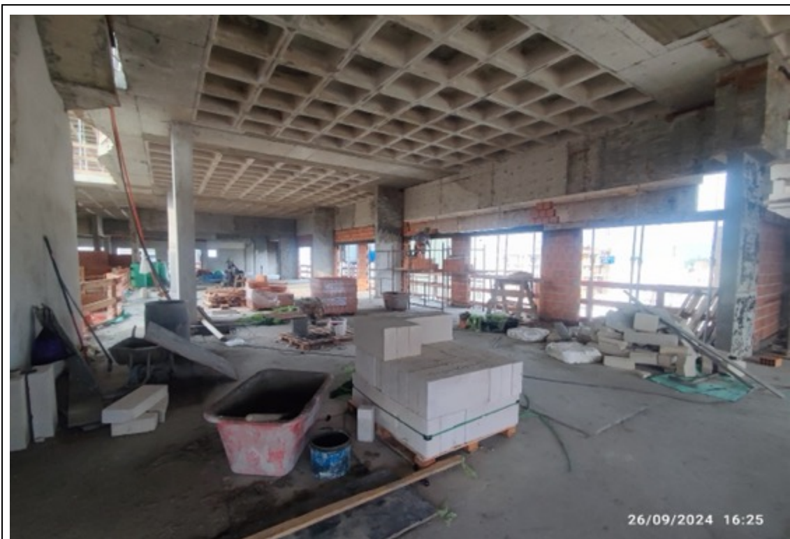
Foto 33 – Execução de alvenaria
