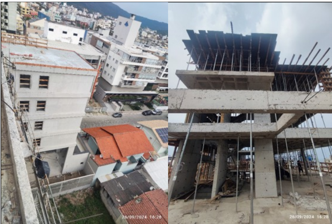
Foto 41 – Vista da fachada posterior da recepção
