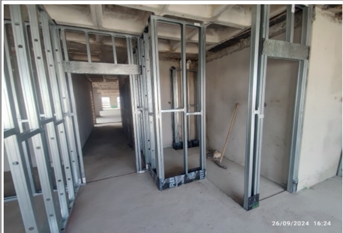
Foto 32 – Execução da estrutura das paredes de drywall
