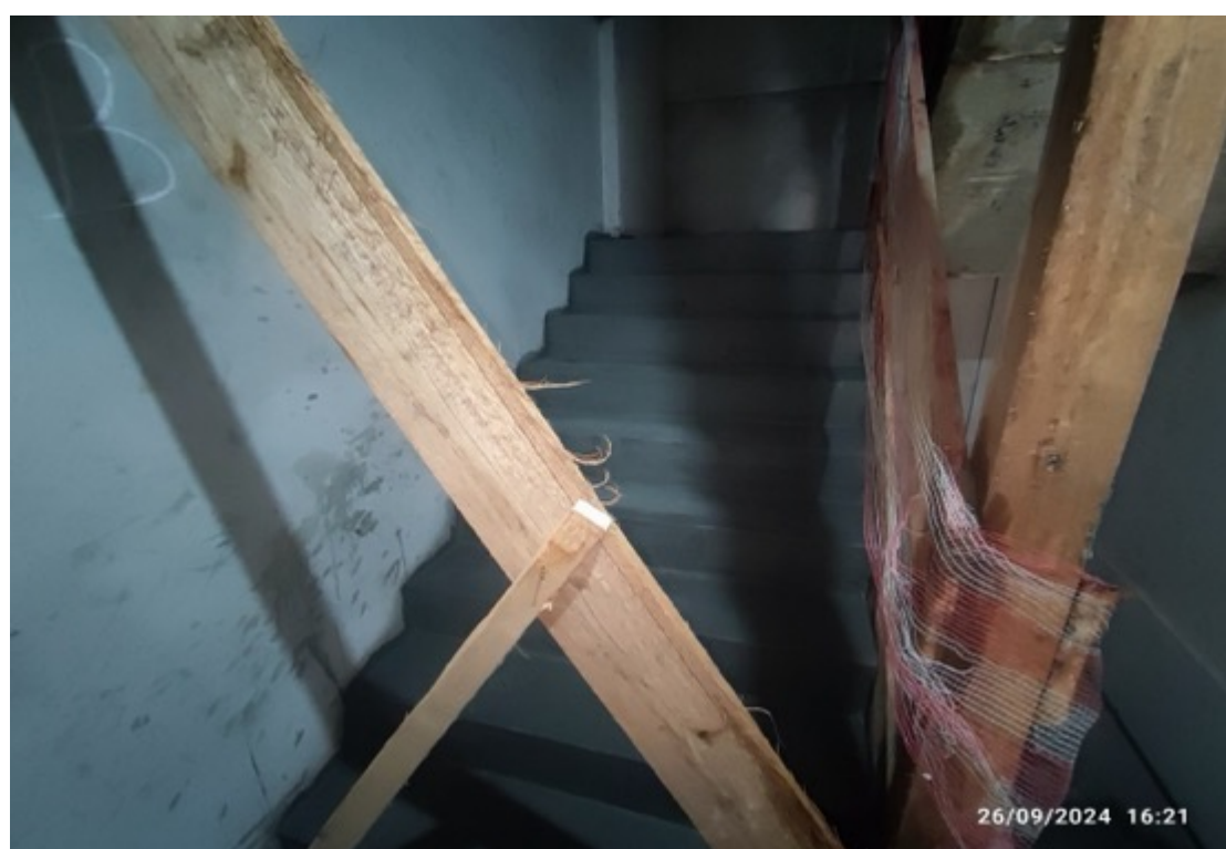
Foto 23 – Execução de contrapiso das escadas
