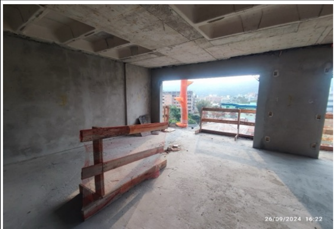
Foto 26 – Limpeza dos pavimentos
