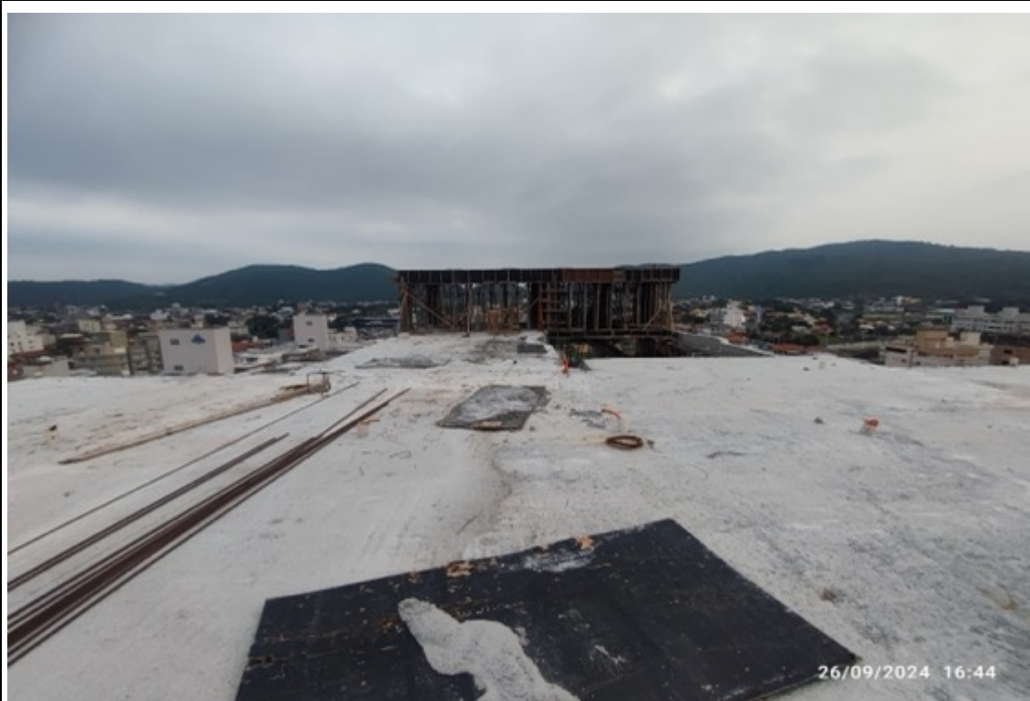
Foto 47 – Laje do heliponto
