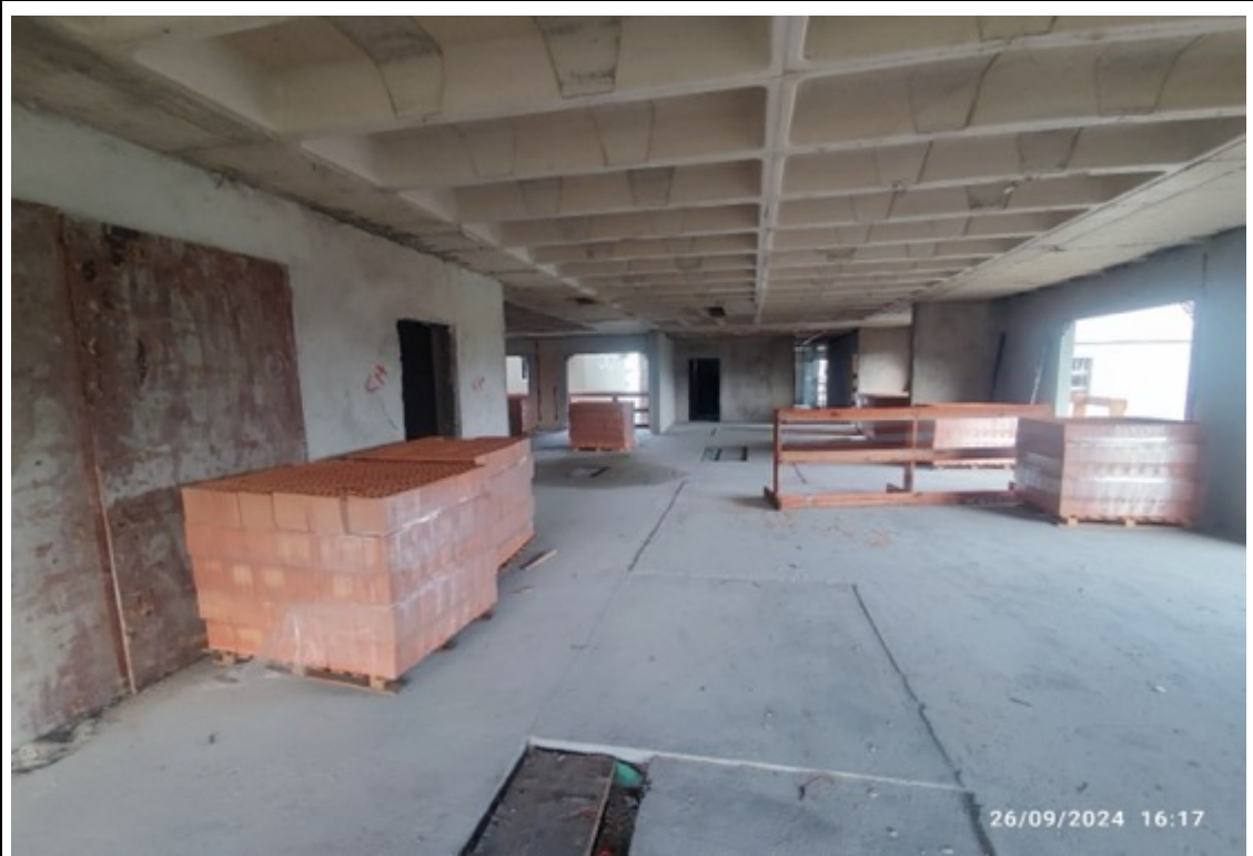
Foto 18 – Estoque de blocos para iniciar alvenaria no pavimento
