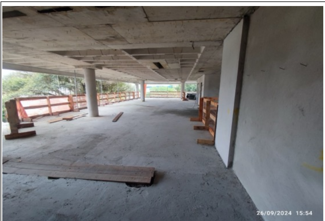
Foto 7 – Limpeza e marcação para colocação de estrutura das paredes de drywall
