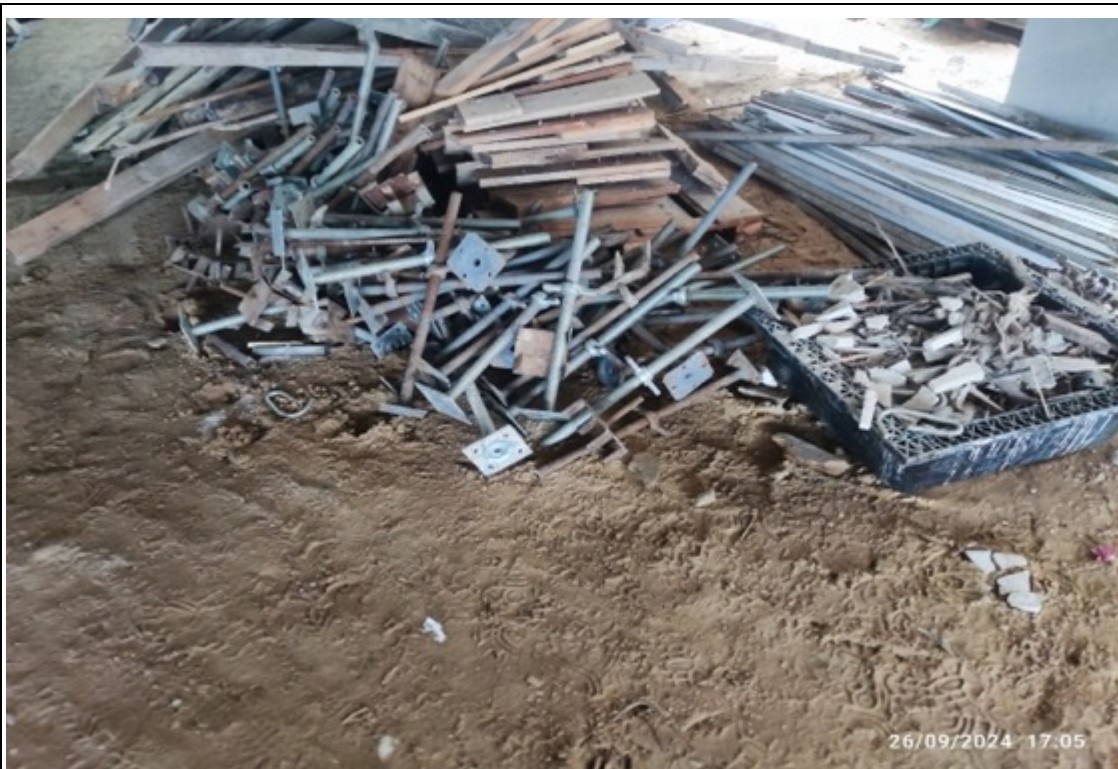
Foto 52 – Devolução de escoramento metálico
