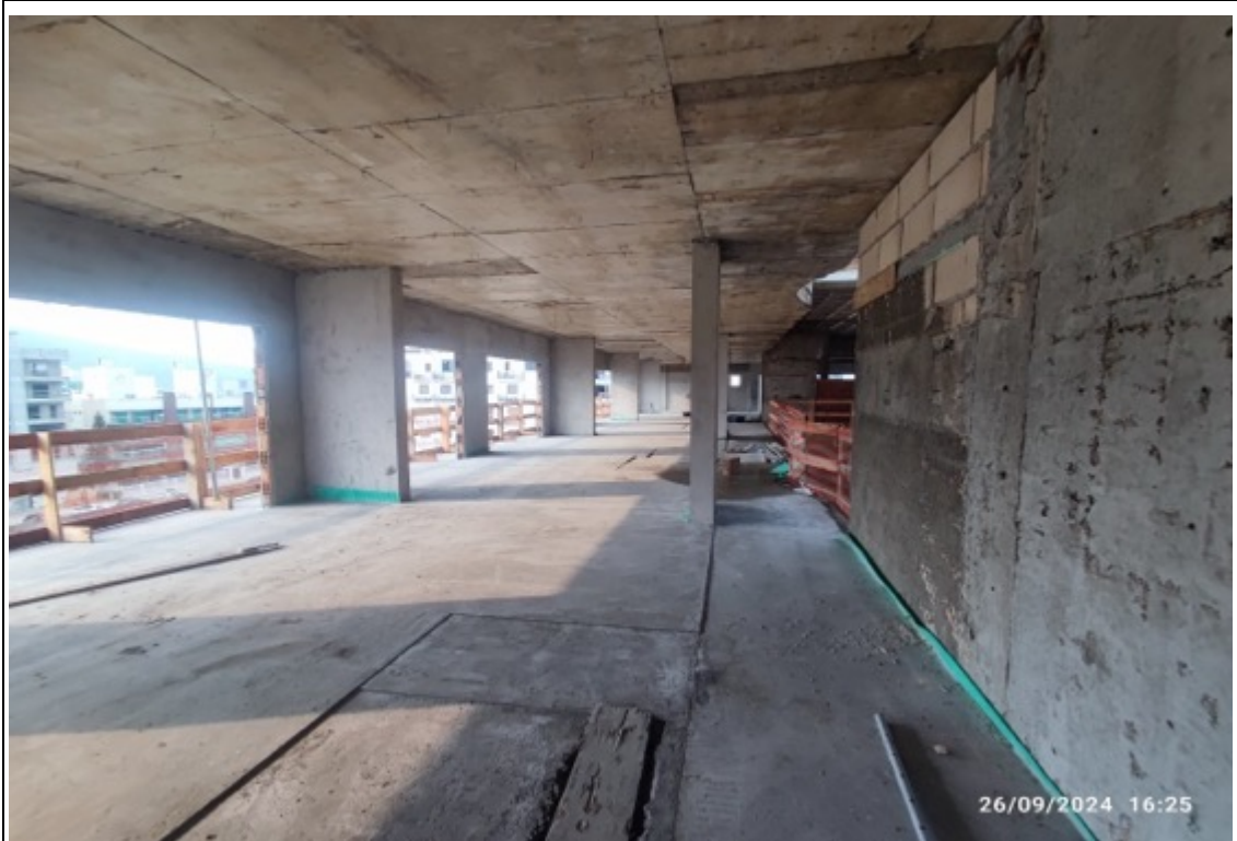
Foto 34 – Limpeza dos pavimentos
