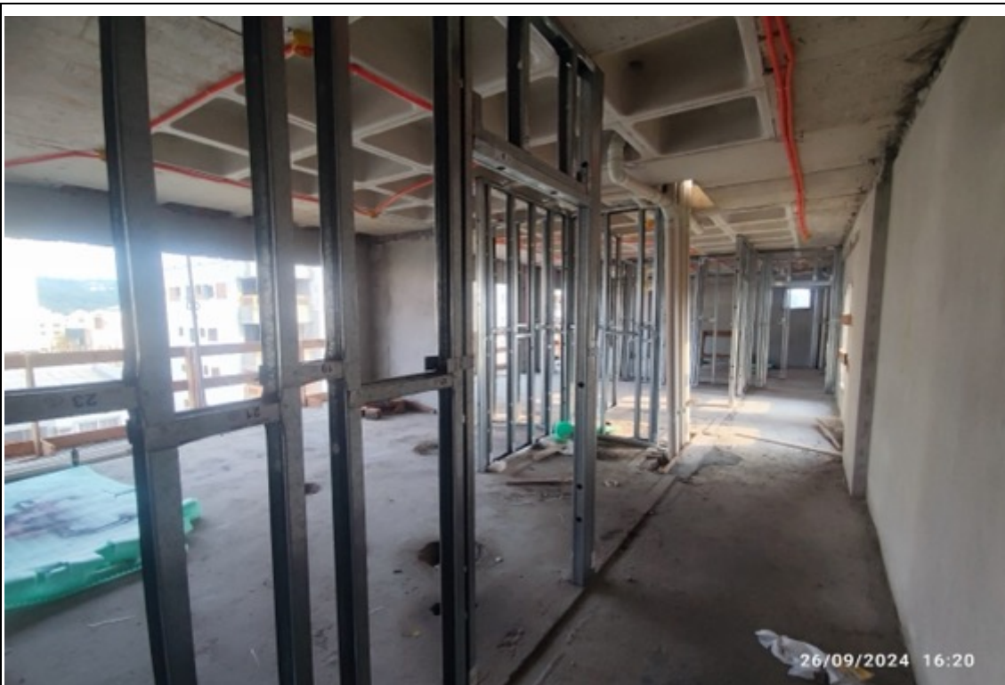
Foto 21 – Execução de estrutura das paredes das suítes
