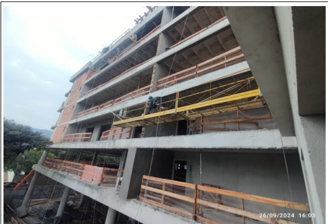
Foto 11 – Execução da fachada
