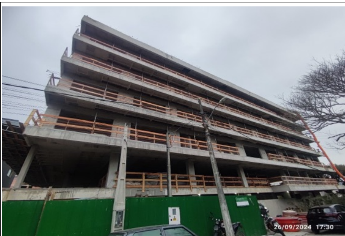
Foto 54 – Fachada na rua Pica Pau
