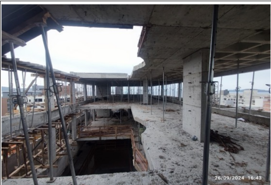
Foto 46 – Escoramento da última laje concretada
