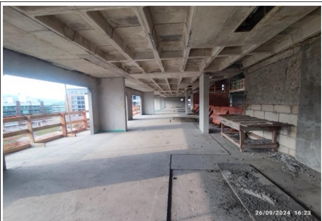
Foto 27 – Limpeza dos pavimentos
