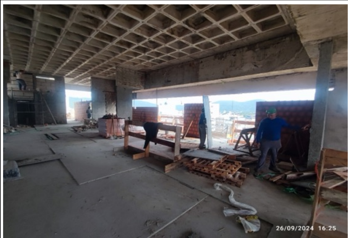
Foto 36 – Execução de alvenaria
