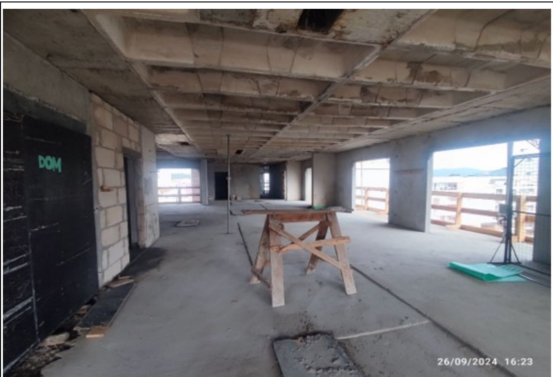
Foto 29 – Limpeza dos pavimentos
