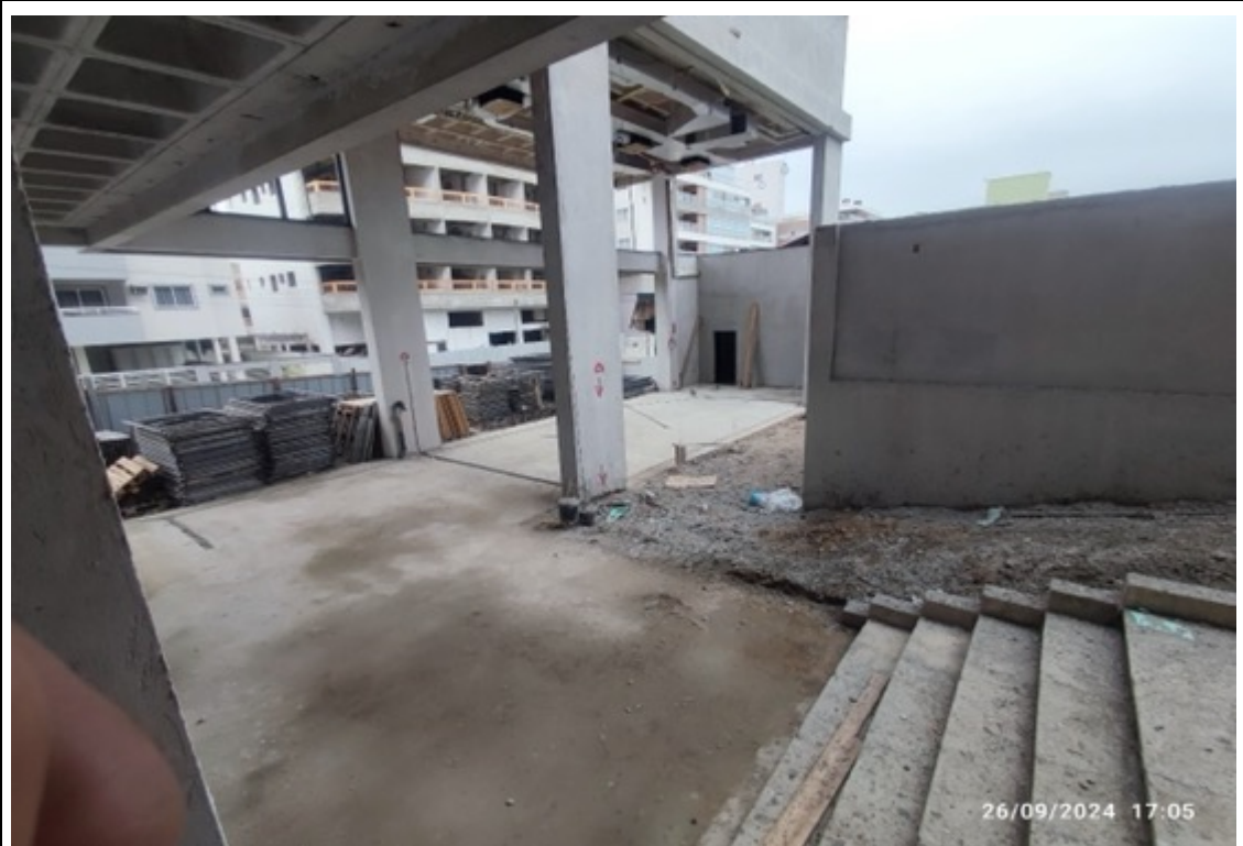
Foto 49 – Execução de marcações para hidráulica e elétrica na recepção
