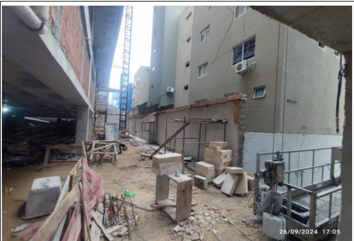
Foto 50 – Execução de alvenaria do muro de divisa
