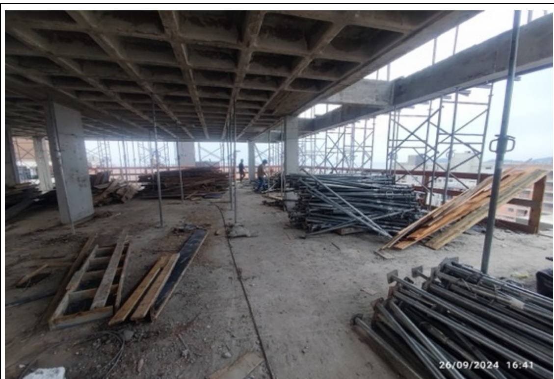
Foto 44 – Retirada de escoramento e organização para devolução
