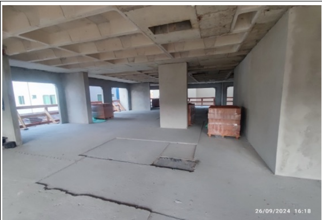
Foto 19 – Limpeza e marcação para estruturas das paredes das suítes
