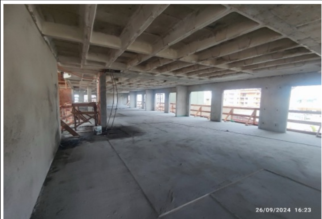
Foto 30 – Limpeza dos pavimentos
