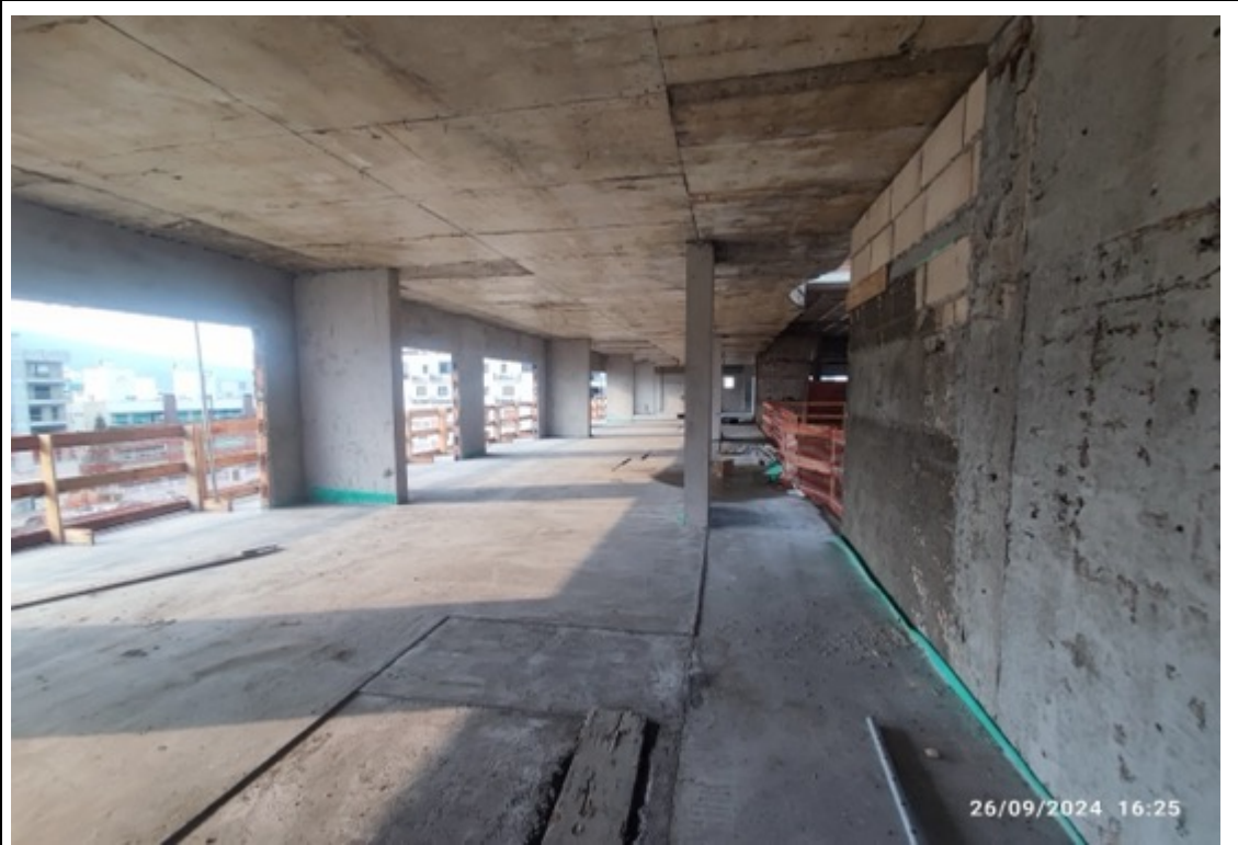
Foto 28 – Limpeza dos pavimentos
