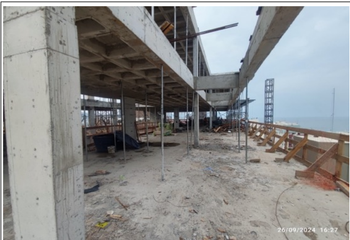
Foto 39 – Limpeza após retirada do escoramento
