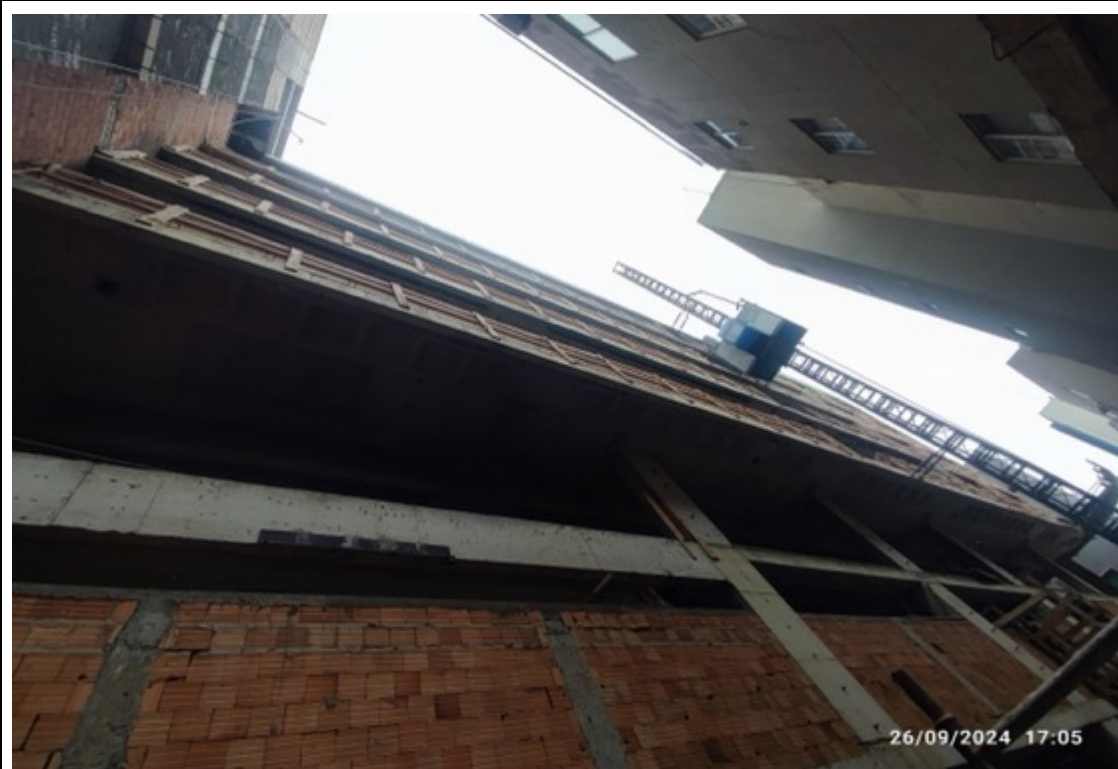
Foto 51 – Fachada posterior do empreendimento
