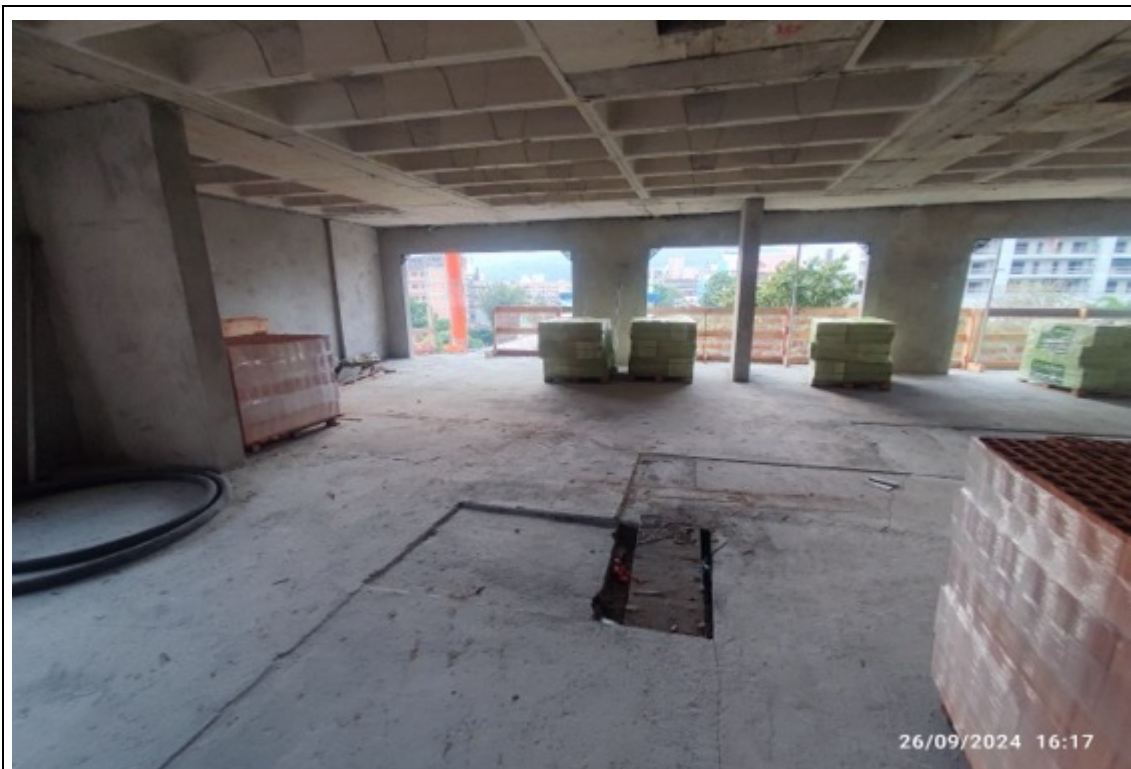
Foto 17 – Estoque de blocos para iniciar alvenaria no pavimento
