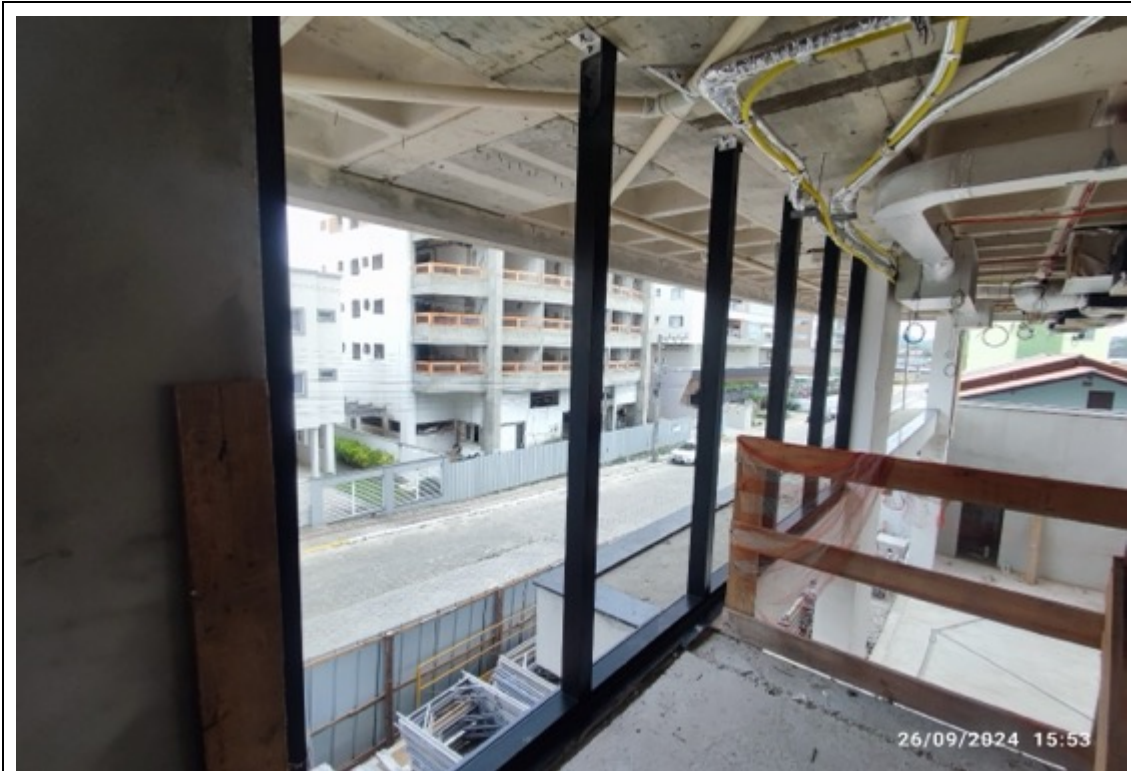
Foto 3 – Instalação de caixilhos da recepção
