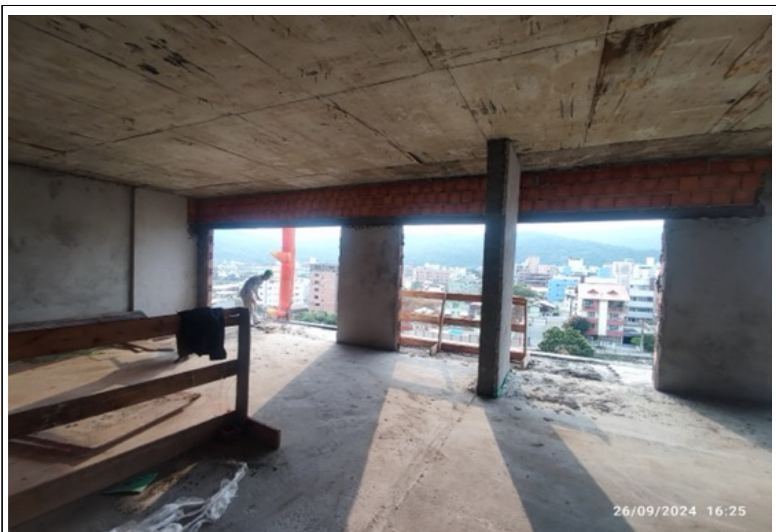
Foto 35 – Limpeza dos pavimentos
