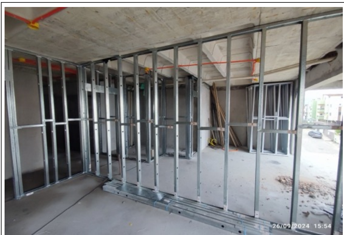
Foto 9 – Estrutura das paredes de drywall das suítes
