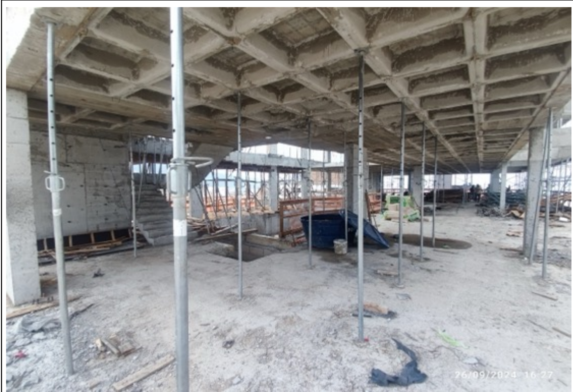
Foto 40 – Escoramento da laje
