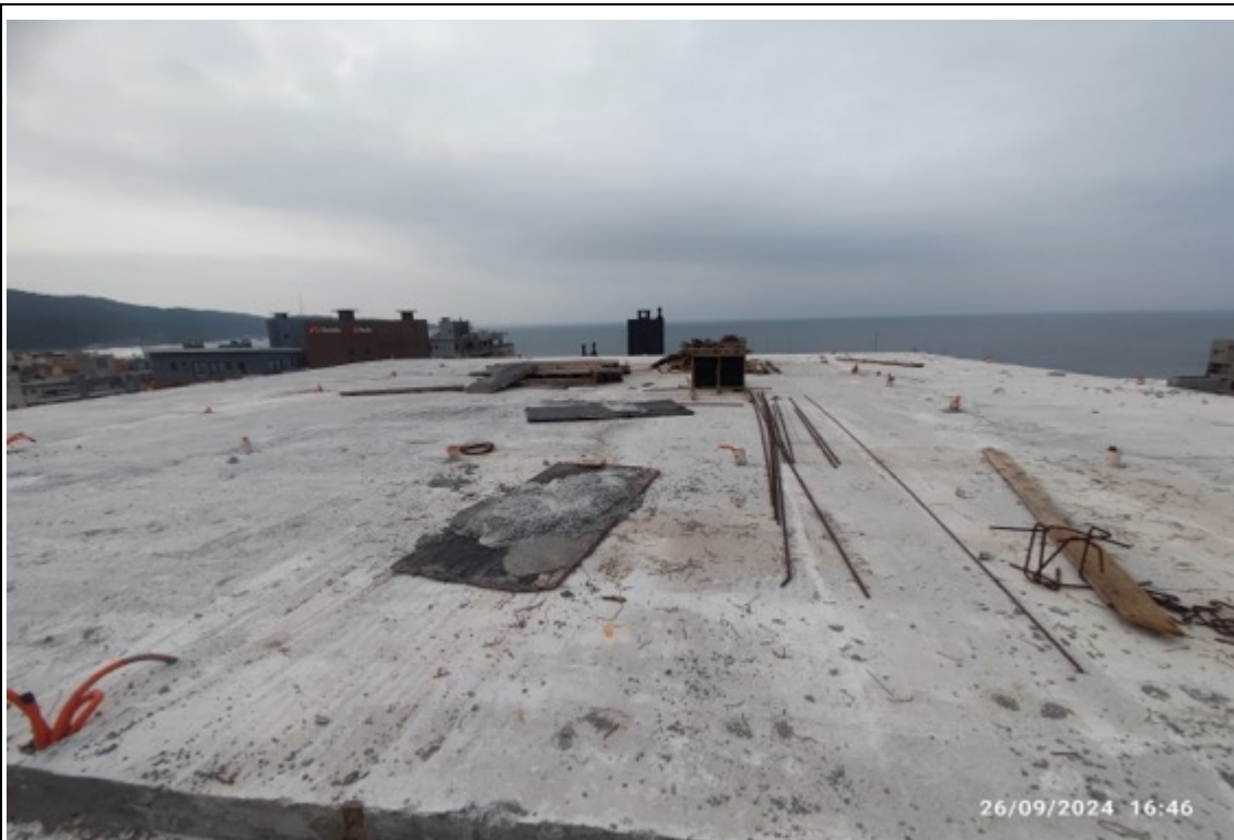
Foto 48 – Laje do heliponto
