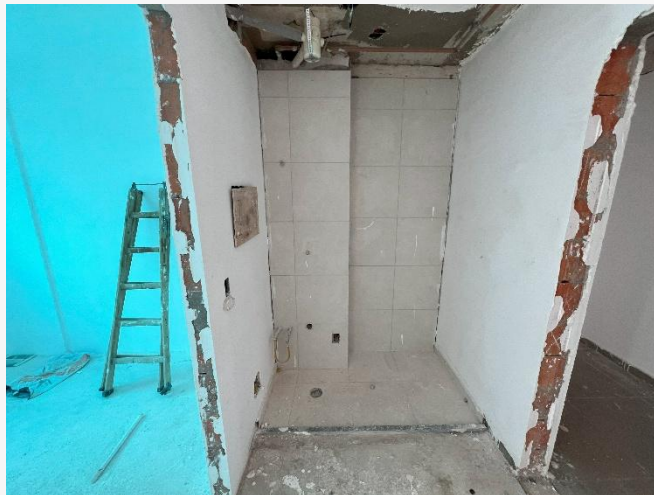
Revestimento Cerâmico – 14º Pav.
