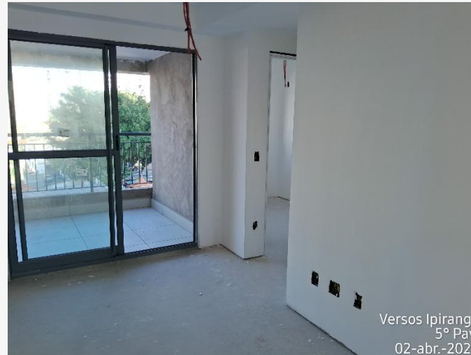
Esquadria de Alumínio – 5º Pav.
