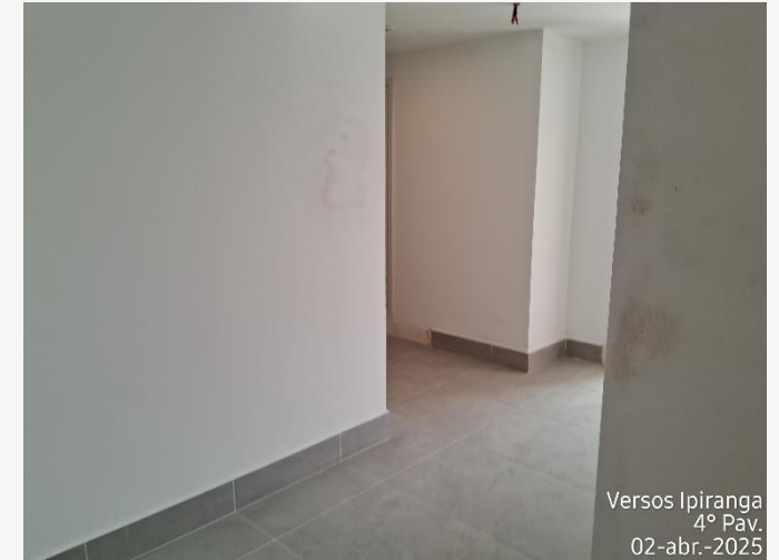
Pintura Interna – 4º Pav.
