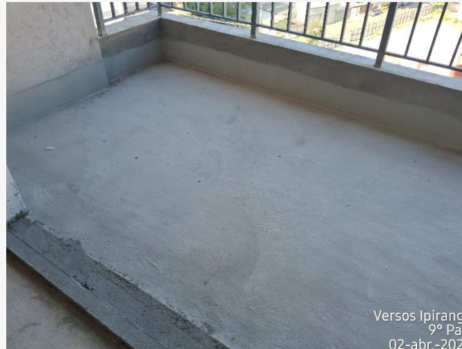
Impermeabilização – 9º Pav.
