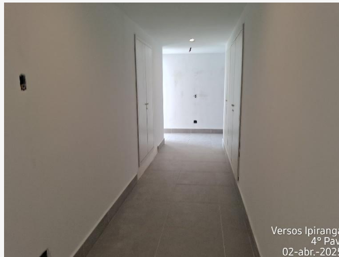
Portas de Shaft – 4º Pav.
