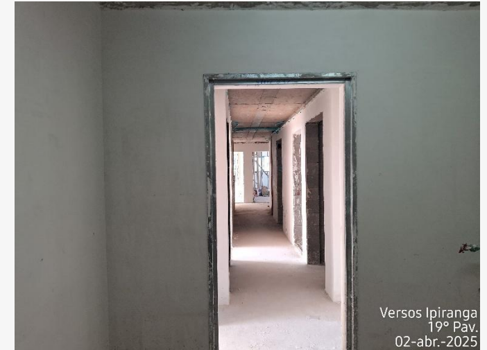
Batente Porta Corta Fogo – 19º Pav.
