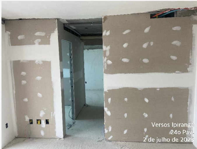
Alvenaria em Drywall – 24º Pav.
