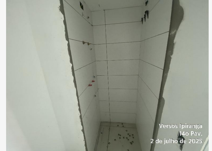
Revestimento Cerâmico – 14° Pav.
