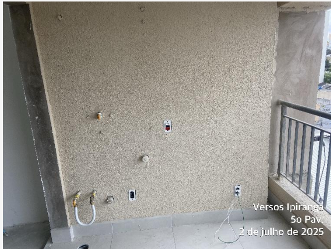
Embutidos em Alvenaria – 5º Pav.
