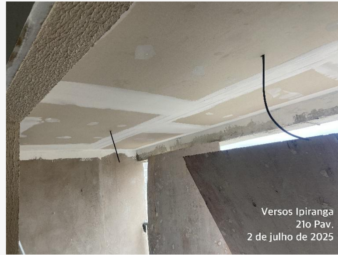
Forro de Gesso Acartonado – 21º Pav.
