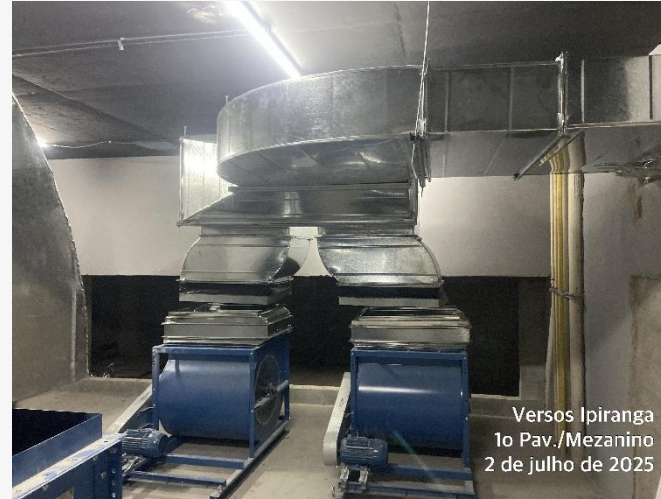
Exaustão Mecânica – 1º Pav.
