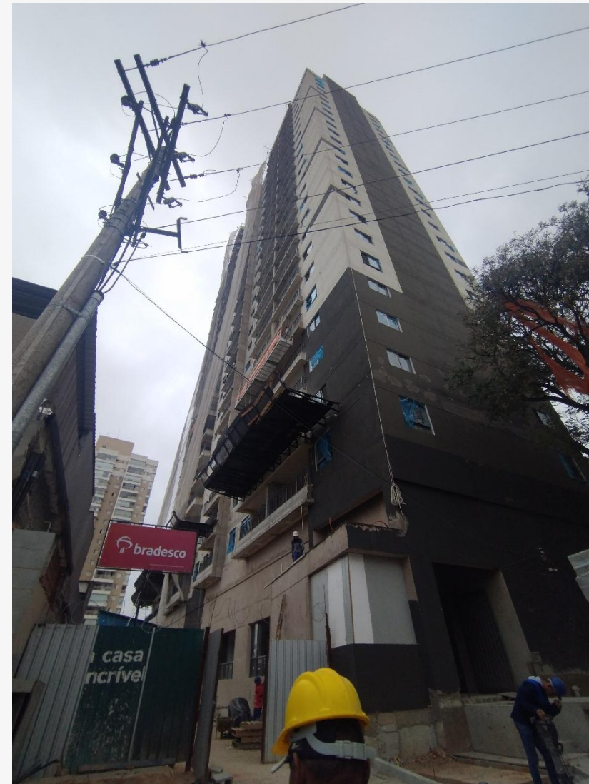
Vista Fachada Lateral
