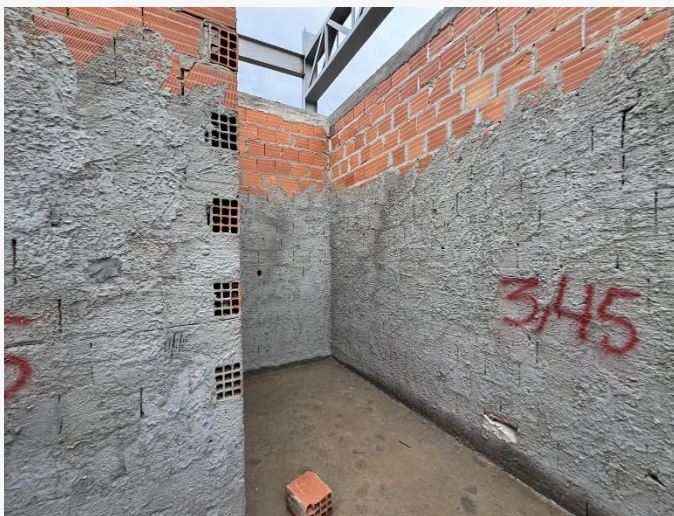
Chapisco Interno – 2º Pav.
