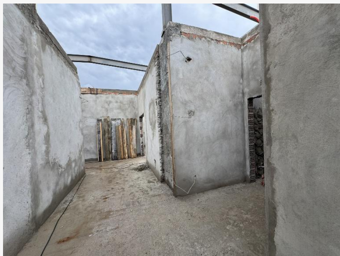
Reboco Interno – 2º Pav.
