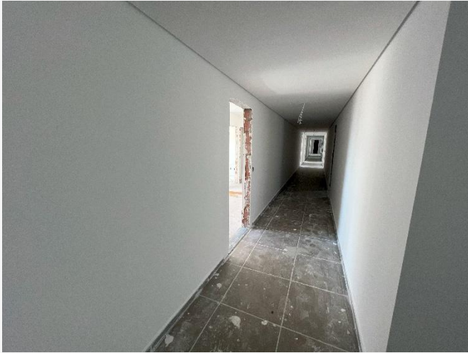
Pintura Interna – 10º Pav
