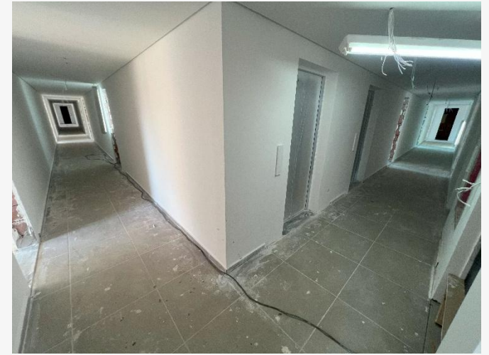
Pintura Interna – 7º Pav
