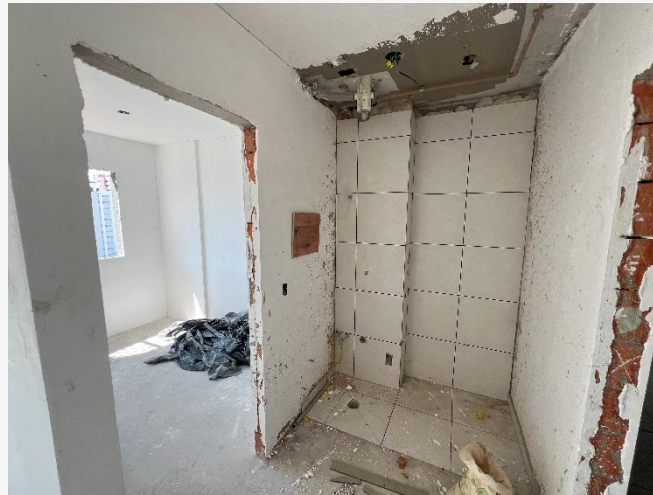
Revestimento Cerâmico – 13º Pav
