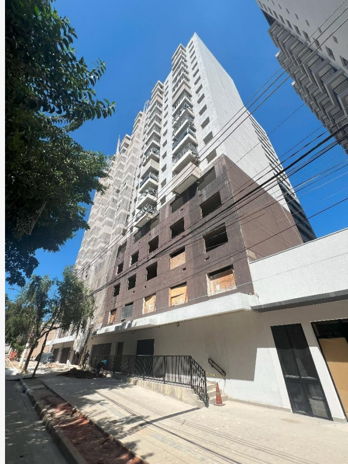
Vista Fachada Lateral
