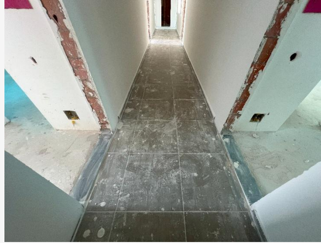
Piso Cerâmico – 8º Pav
