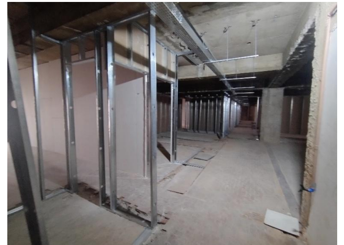
Alvenaria Drywall – 7º Pav
