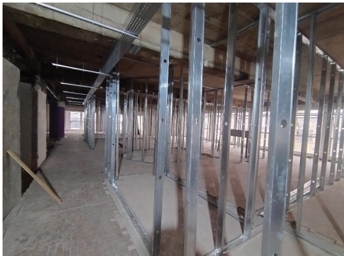
Estrutura Drywall – 5º Pav
