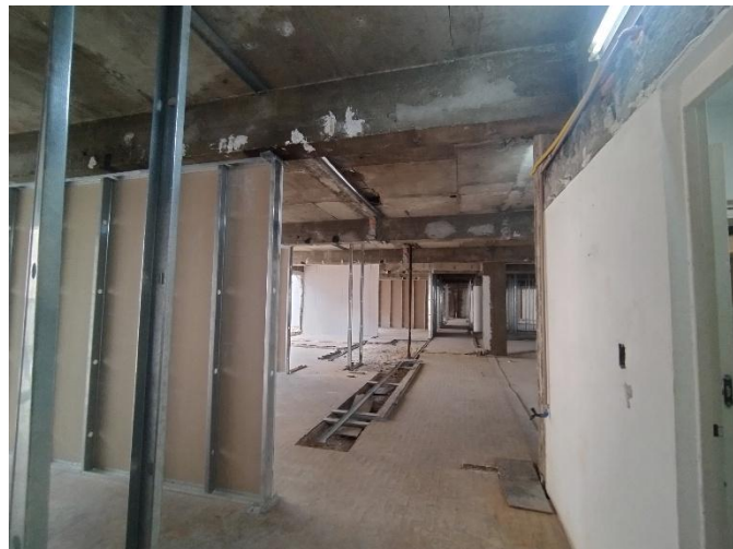
Alvenaria Drywall – 8º Pav
