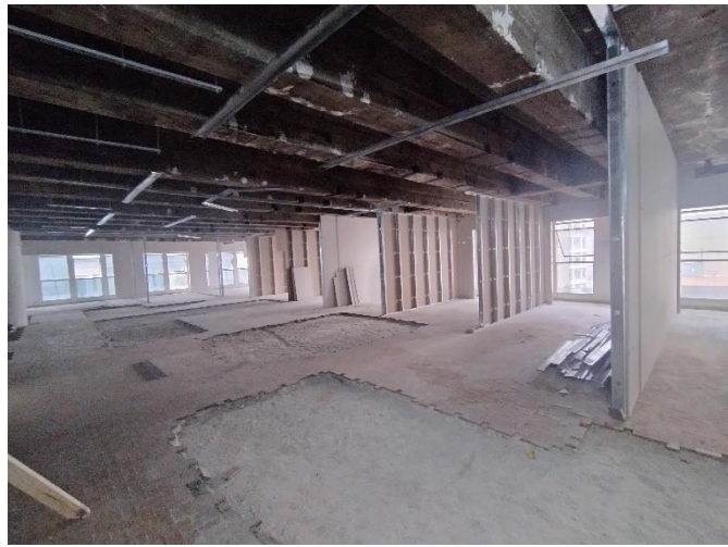
Alvenaria Drywall – 7º Pav
