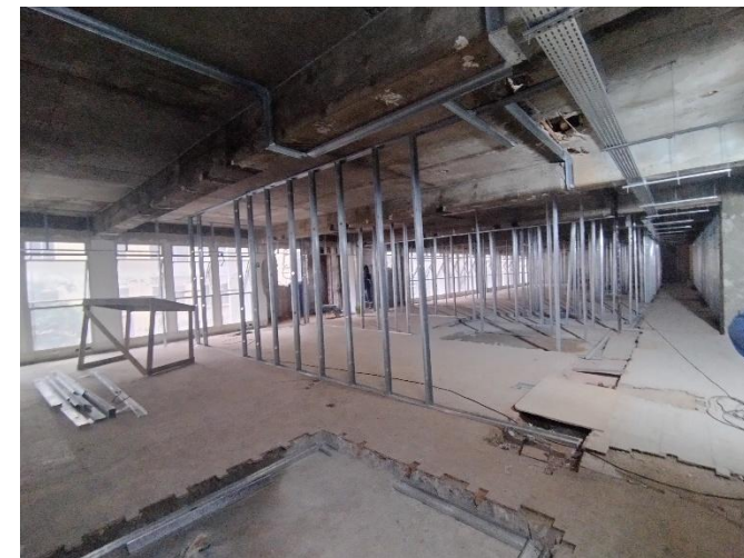
Estrutura Drywall – 3º Pav
