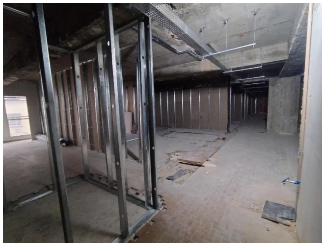
Estrutura Drywall – 4º Pav
