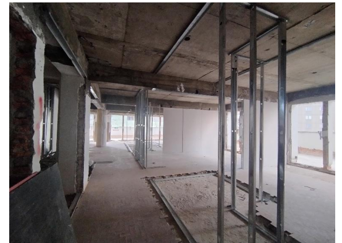
Estrutura Drywall – 8º Pav
