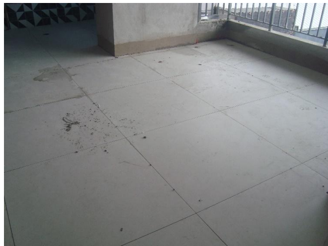
Piso Cerâmico – 2° Pav
