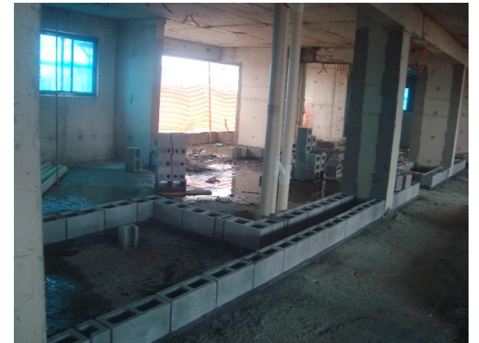
Marcação de Alvenaria – 22° Pav
