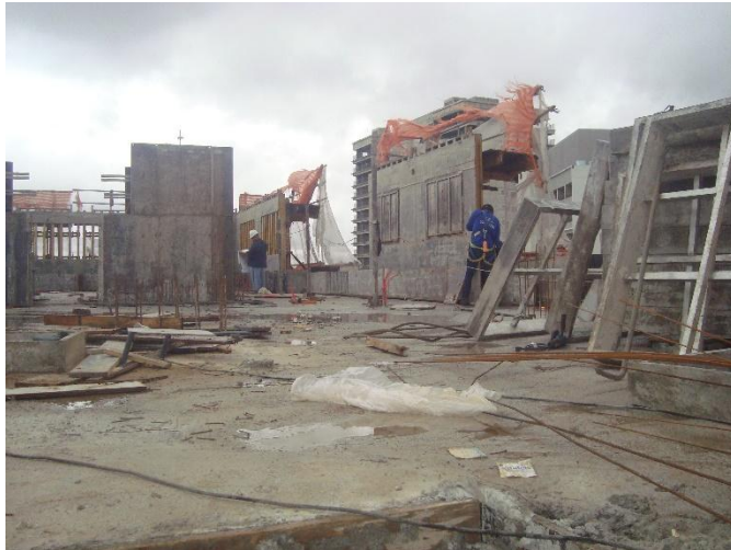
Laje Concretada – 26° Pav
