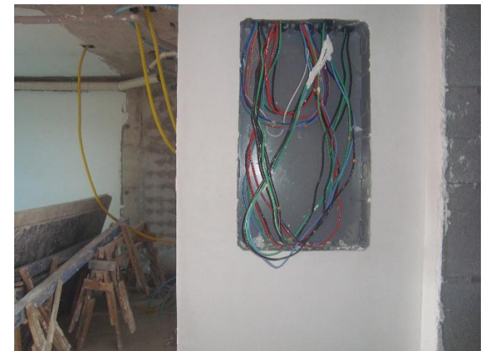
Cabos de Instalação – 16° Pav
