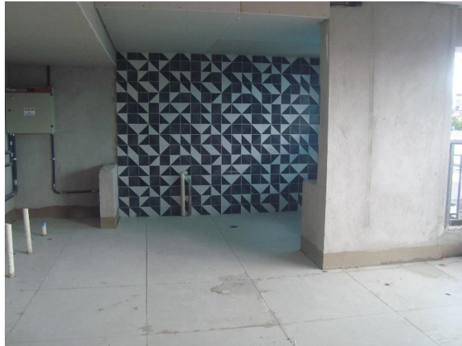
Revestimento Cerâmico – 2º Pav
