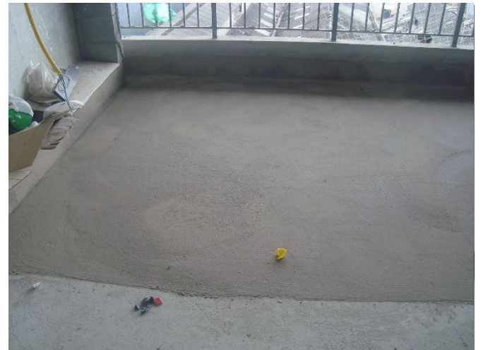
Impermeabilização – 2° Pav
